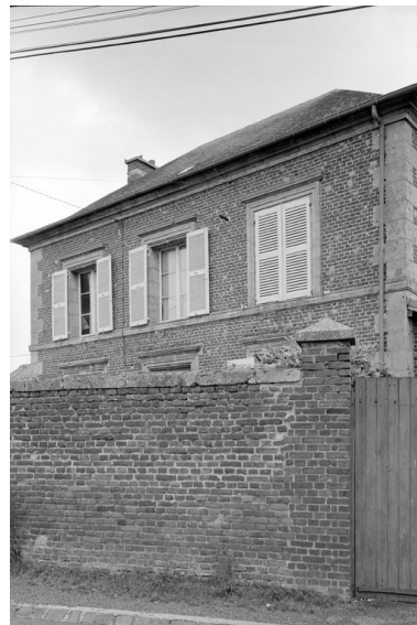
Elévation antérieure. Phot. Jean-Michel Perrin IVR22_19846000958X
