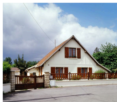
Maison de la cité de la Tonnellerie Phot. Thierry Lefébure IVR22_20076000084XA
