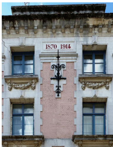
Vue de détail de la façade sur rue : dates portées 1870-1914.
