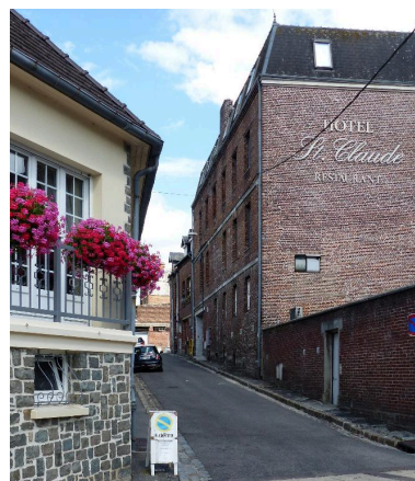
Vue depuis la rue Charles-le-Téméraire. Phot. Isabelle Barbedor IVR32_20178005276NUCA
