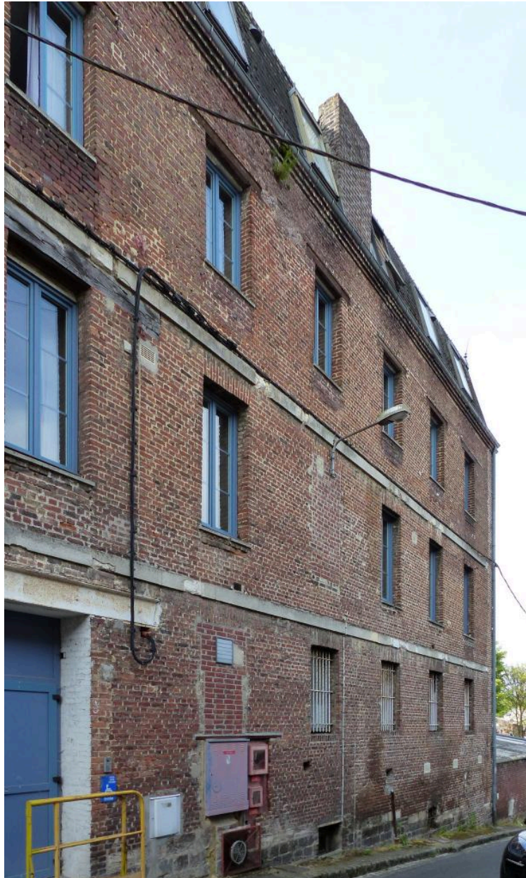
Vue de la façade sur la rue Charles-le-Téméraire.
