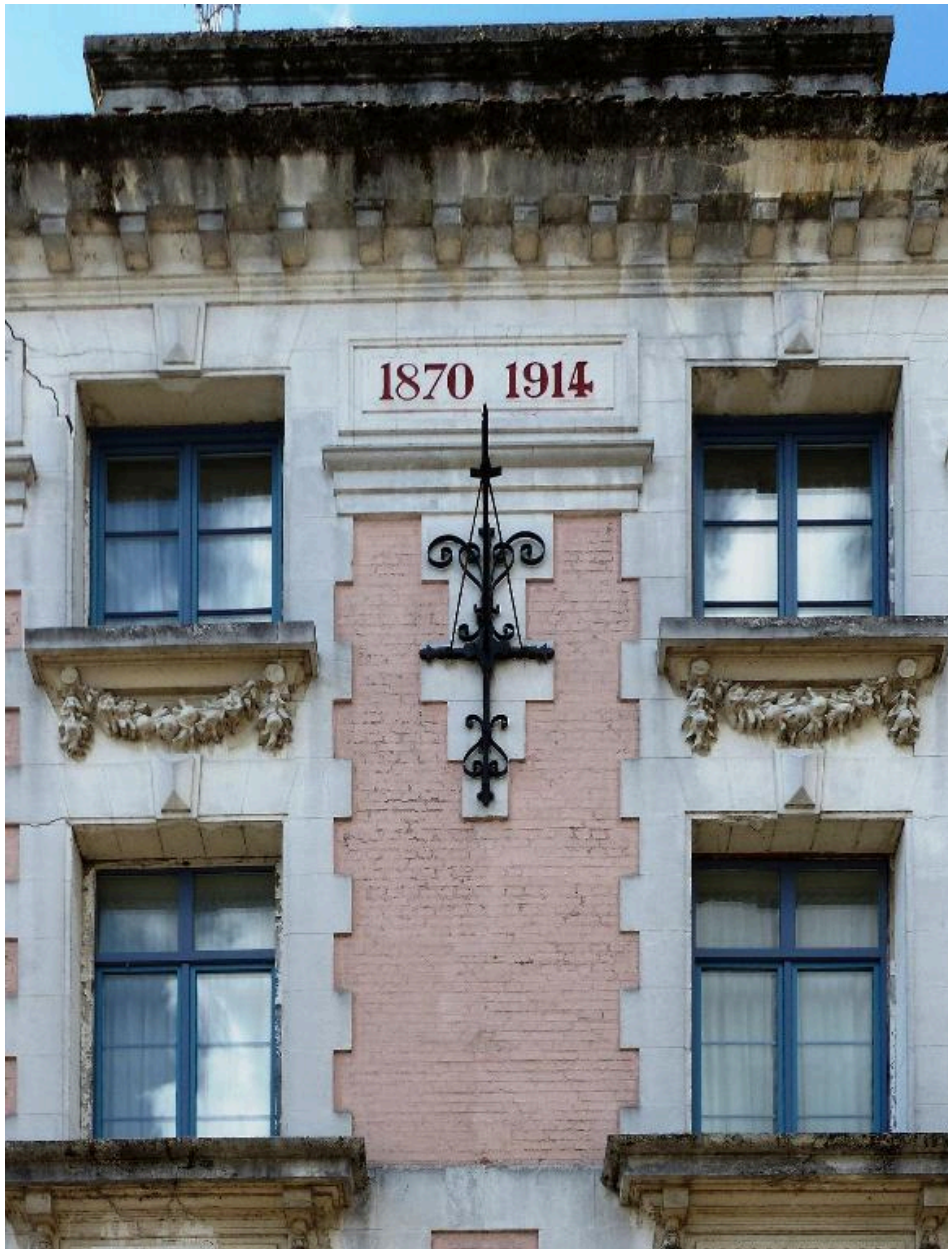
Vue de détail de la façade sur rue : dates portées 1870-1914.
