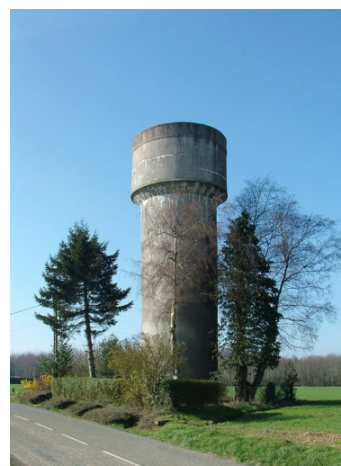
Château d'eau, vers 1965. Phot. Frédéric Fournis IVR22_20118001124NUCA
