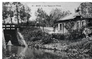
Vue des vannes de l'étang, vers 1930 (coll. part.). Phot. Bürjes Franck (reproduction) IVR22_19980205044ZB
