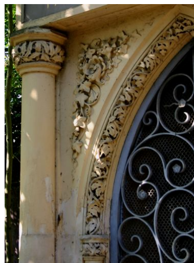
Façade principale du tombeau- chapelle : écoinçon gauche orné d'un décor sculpté de feuilles de lierre. Phot. Caroline Vincent IVR22_20068001356NUCA
