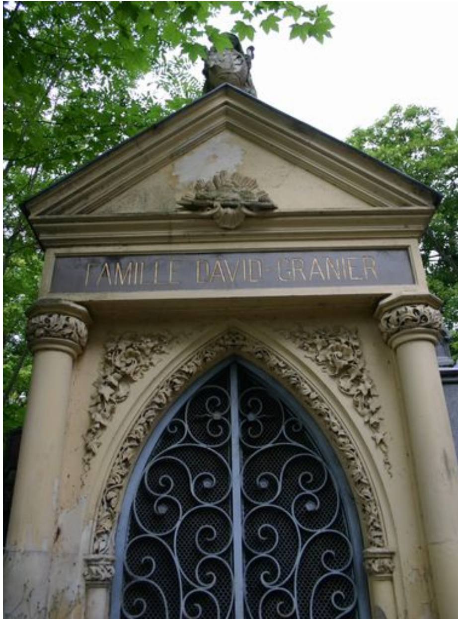
Façade principale du tombeau-chapelle (partie supérieure).
