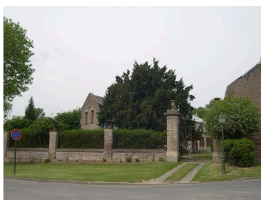
Vue de situation. Phot. Isabelle Barbedor IVR22_20038010417NUCA
