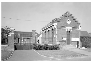
La mairie-école. Phot. Irwin Leullier IVR22_19978000819X
