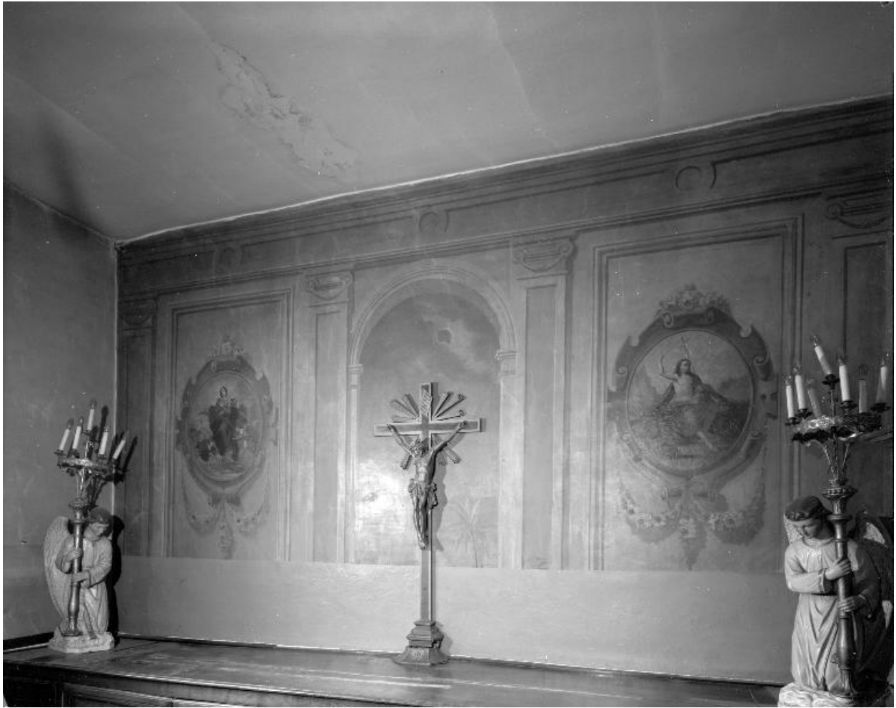
Rez-de-chaussée, sacristie, vue de la paroi portant à sa partie supérieure un décor peint en trompe l'oeil (XIXe siècle ?).
