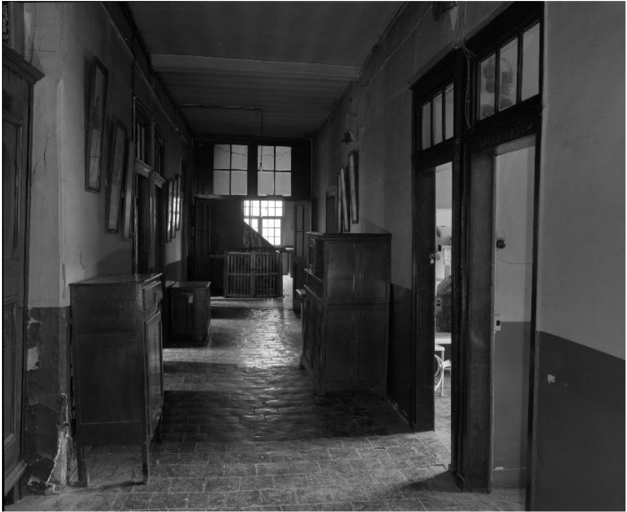
1er étage, section affectée au logement de la communauté religieuse, couloir desservant quatorze cellules, vue en enfilade.
