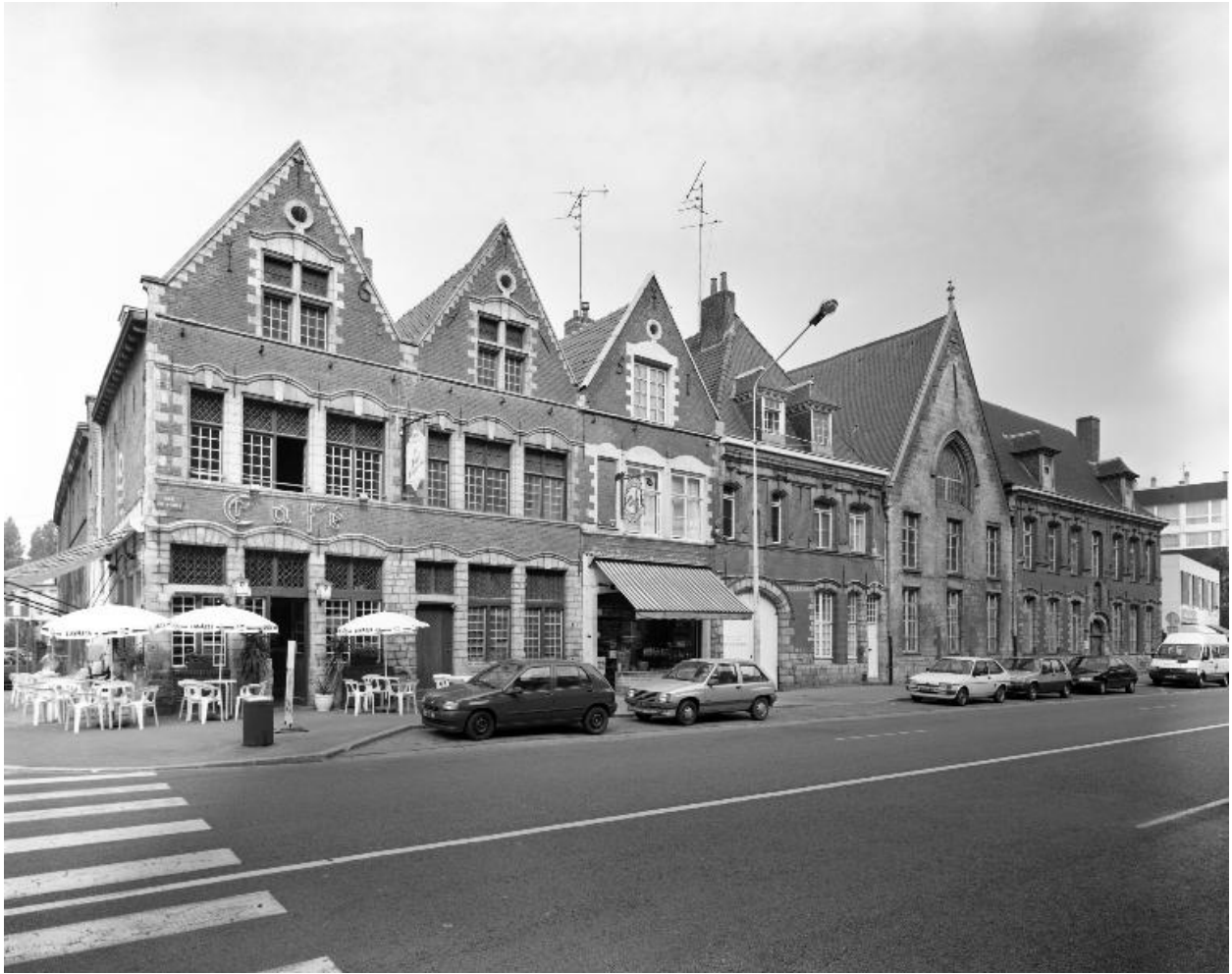
Elévation sur la rue de Paris, vue générale prise de trois-quarts gauche.
