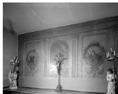
Rez-de-chaussée, sacristie, vue de la paroi portant à sa partie supérieure un décor peint en trompe l'oeil (XIXe siècle ?). Phot. Pierre Thibaut IVR31_19945901000V
