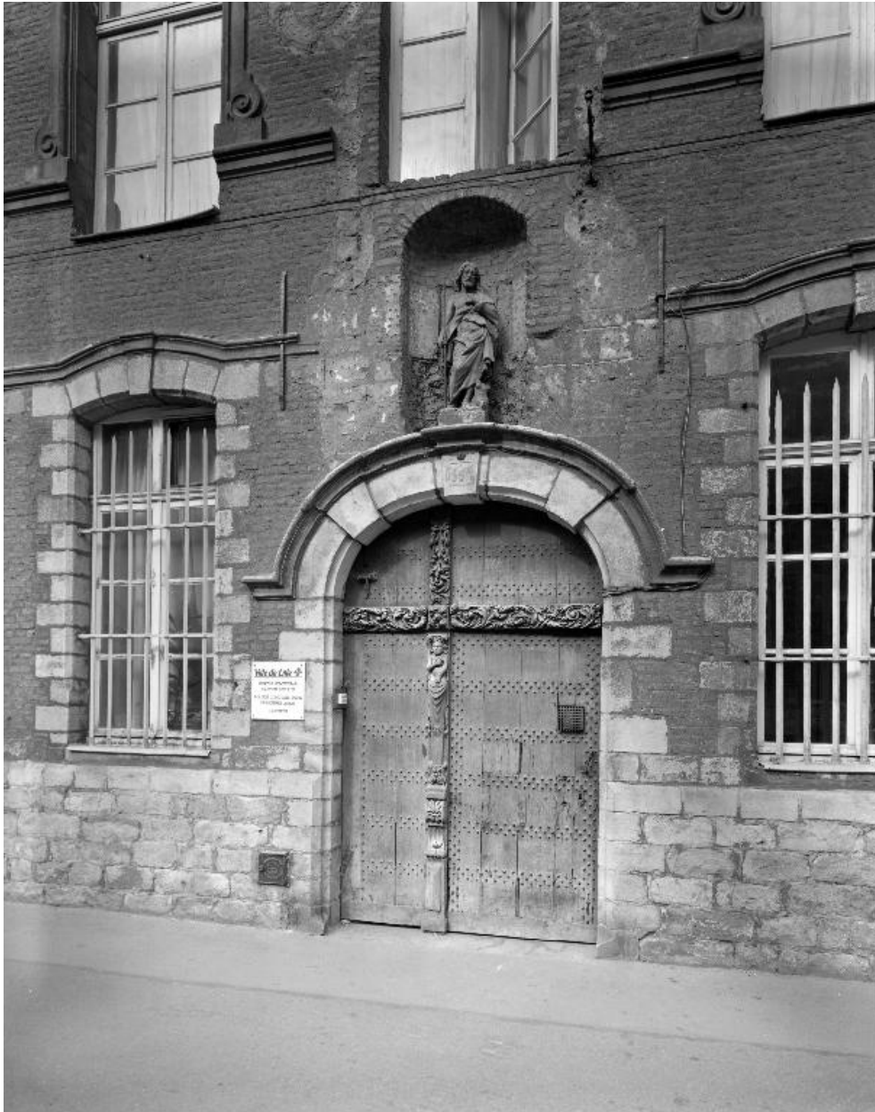
Elévation sur la rue de Paris, détail du portail d'entrée surmonté d'une niche abritant une statue de saint Roch.
