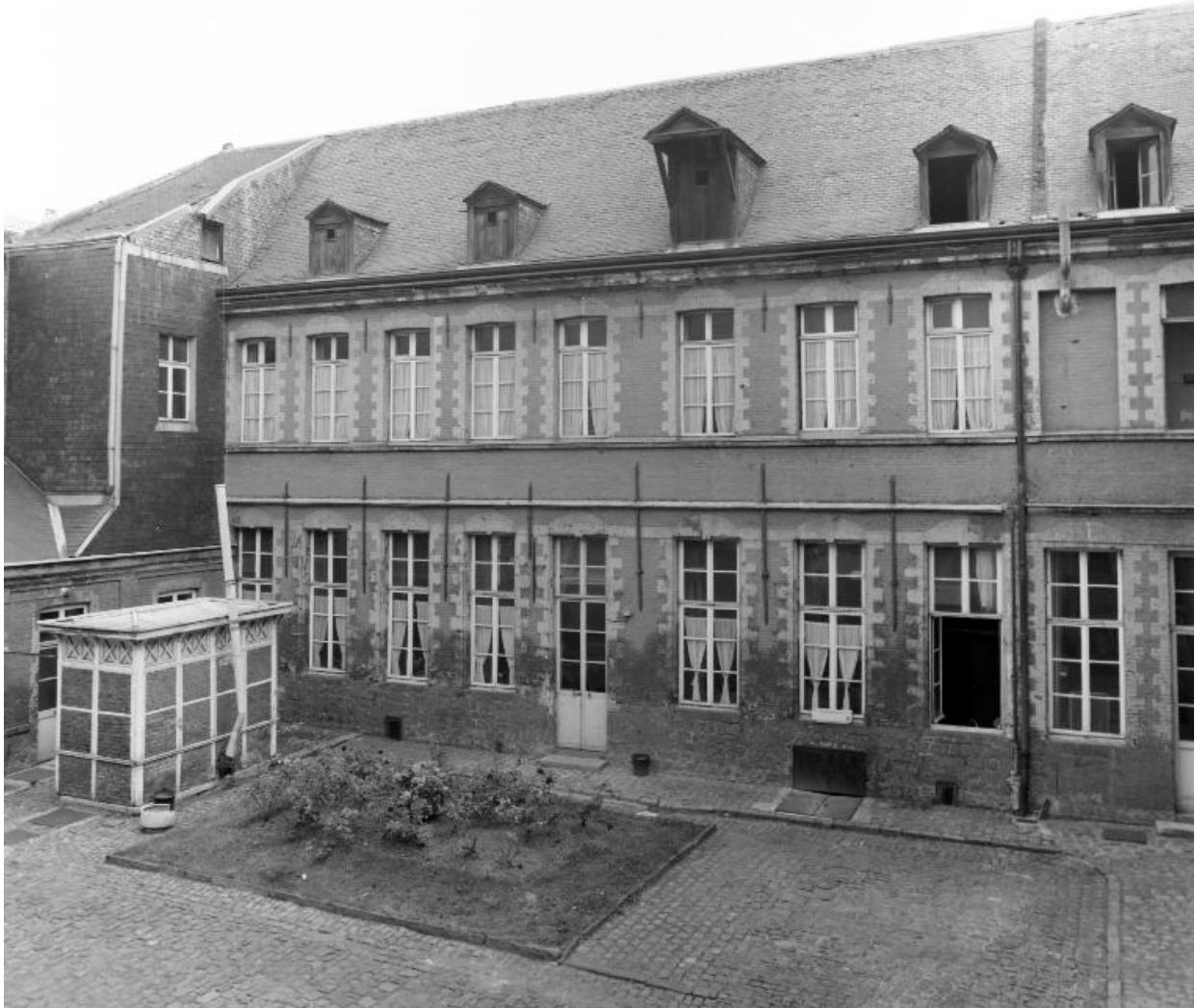
Bâtiment bordant le côté sud de la cour de service, élévation sur la cour.
