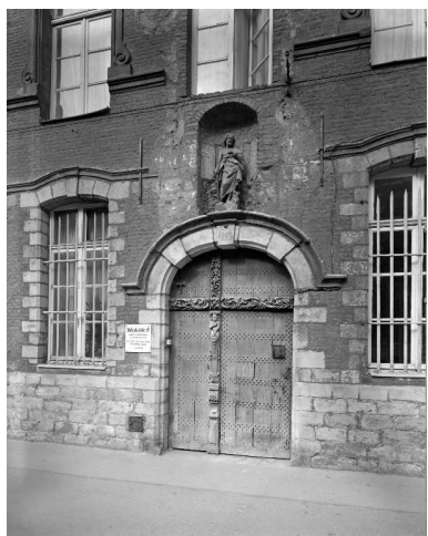
Elévation sur la rue de Paris, détail du portail d'entrée surmonté d'une niche abritant une statue de saint Roch. Phot. Pierre Thibaut IVR31_19945901016V
