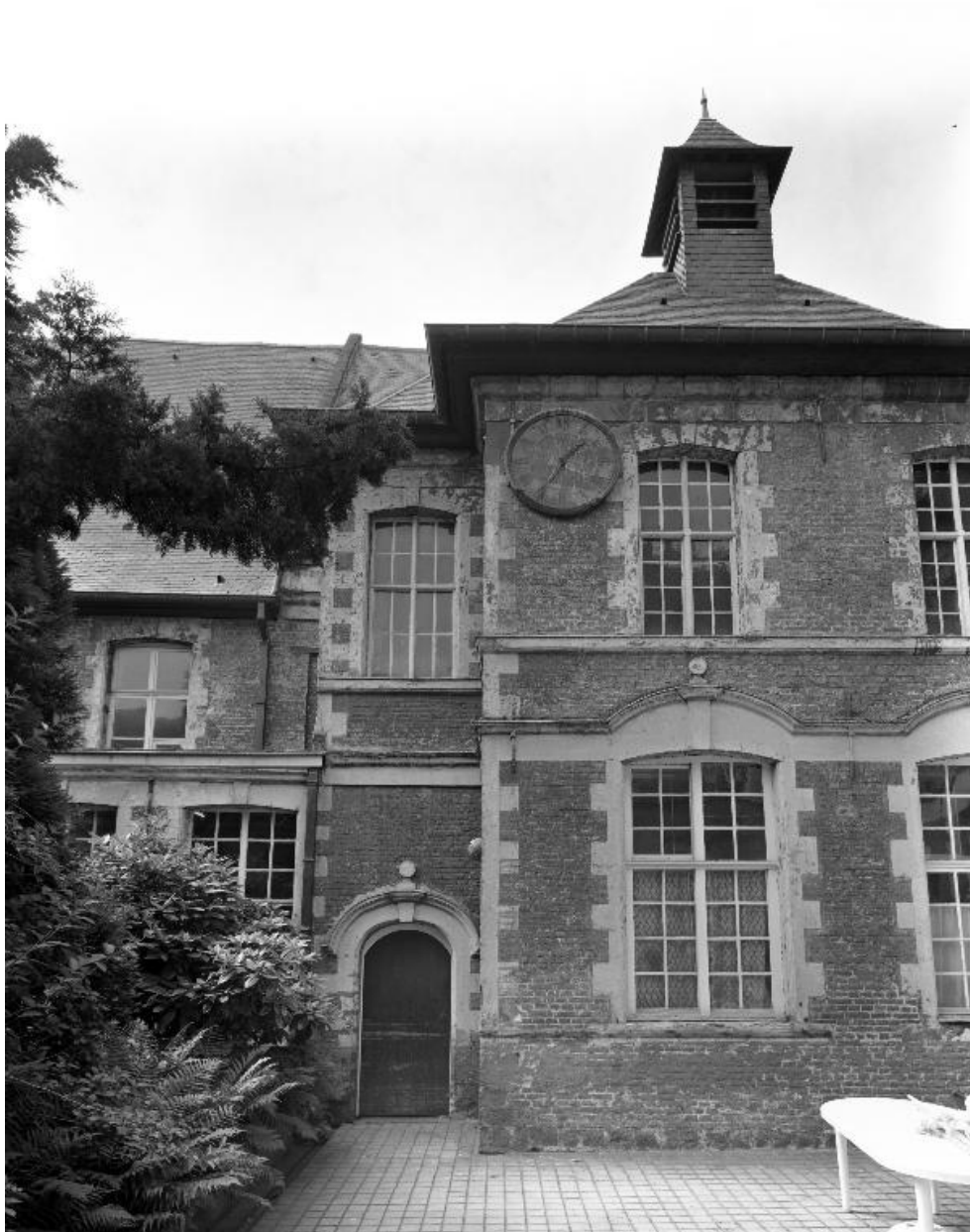
Pavillon occupant l'angle sud-ouest de la cour d'honneur, surmonté d'un clocheton indiquant l'emplacement sous-jacent de l'oratoire des sœurs, élévation sur la cour.
