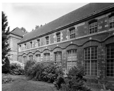
Bâtiment bordant le côté nord de la cour d'honneur, élévation sur la cour.
