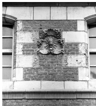
Bâtiment bordant le côté est de la cour d'honneur, élévation sur la cour, détail d'un des cartouches où figure une représentation du saint-sacrement. Phot. Pierre Thibaut IVR31_19945901264X
