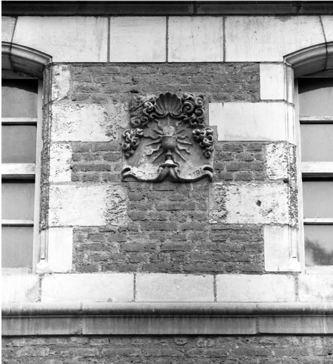
Bâtiment bordant le côté est de la cour d'honneur, élévation sur la cour, détail d'un des cartouches où figure une représentation du saint-sacrement.
