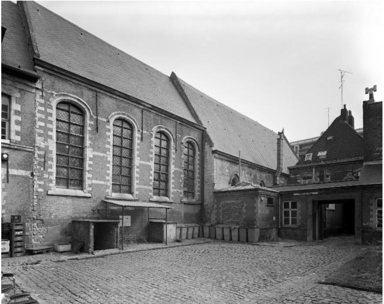
Bâtiment bordant le côté nord de la cour de service renfermant l'ancienne salle des malades avec, dans son prolongement, la chapelle visible ici au premier plan, élévation sur la cour.
