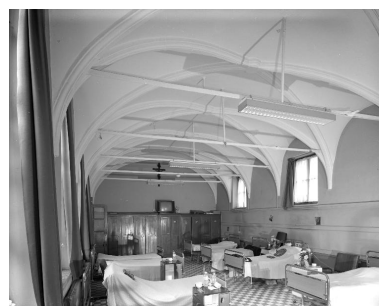
Bâtiment bordant le côté sud de la cour de service, rez-de-chaussée, salle dite dortoir Saint-François, vue générale.
