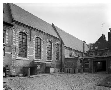
Bâtiment bordant le côté nord de la cour de service renfermant l'ancienne salle des malades avec, dans son prolongement, la chapelle visible ici au premier plan, élévation sur la cour.
