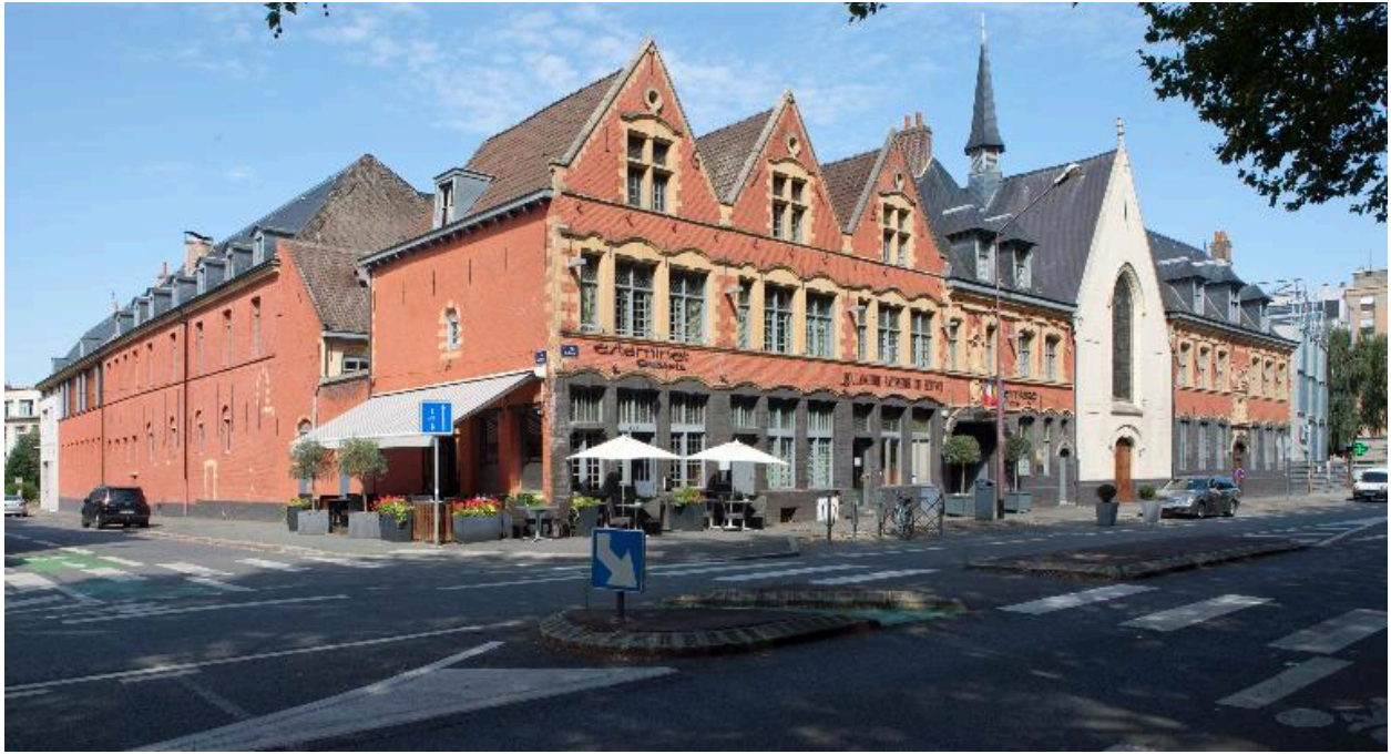
Façade principale donnant sur la rue de Paris et façade latérale sud donnant sur la rue Malpart, vue d'ensemble.
