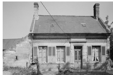
Logis. Elévation antérieure. Phot. Jean-Michel Perrin IVR22_19856000893X
