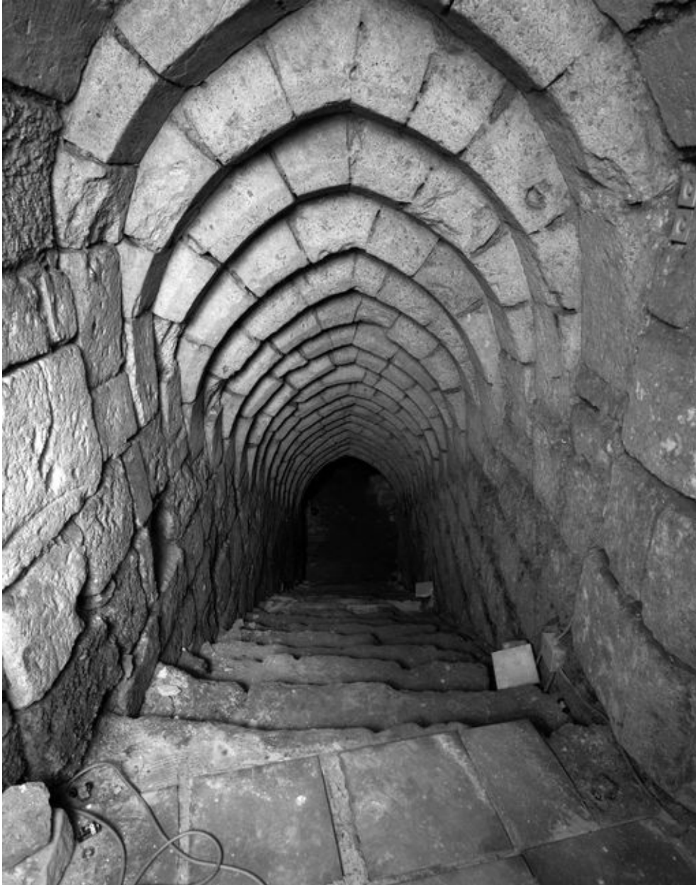
Escalier vers le 2e étage de sous-sol.
