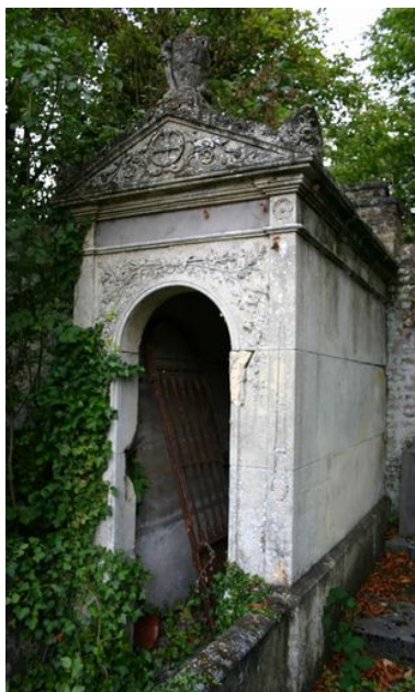
Vue latérale. Phot. Caroline Vincent IVR22_20068001387NUCA
