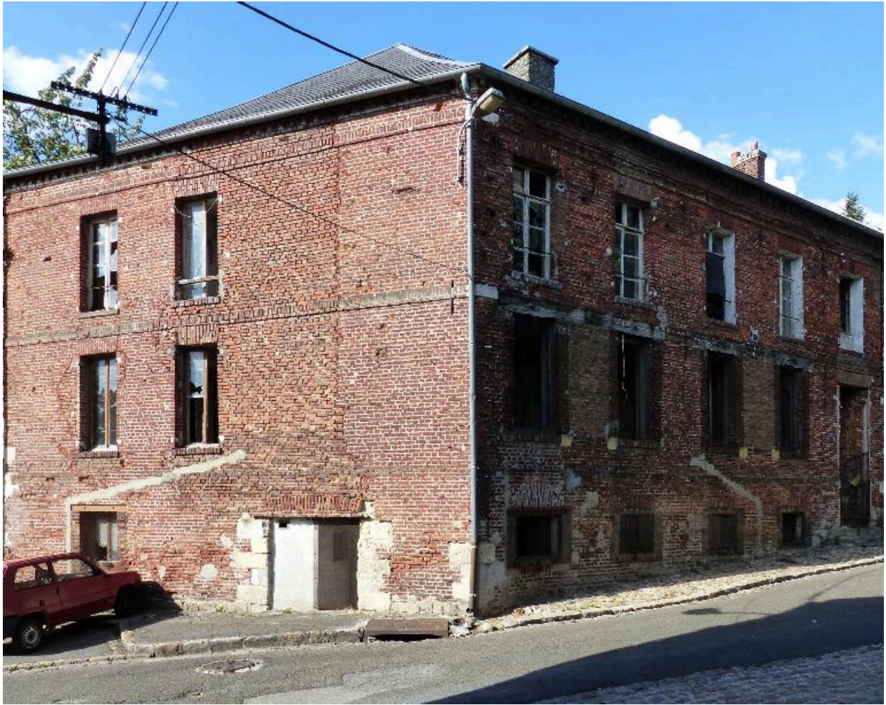
Immeuble de rapport, rue des Chanoines, restauré après la Première Guerre mondiale. Vestiges possibles de la brasserie Fournel.
