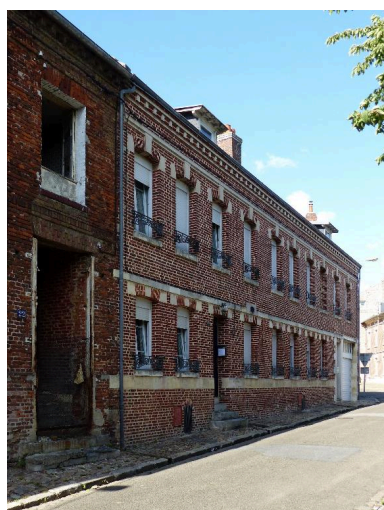
Immeuble de rapport, rue des Chanoines, restauré après la Première Guerre mondiale. Phot. Isabelle Barbedor IVR32_20178005259NUCA
