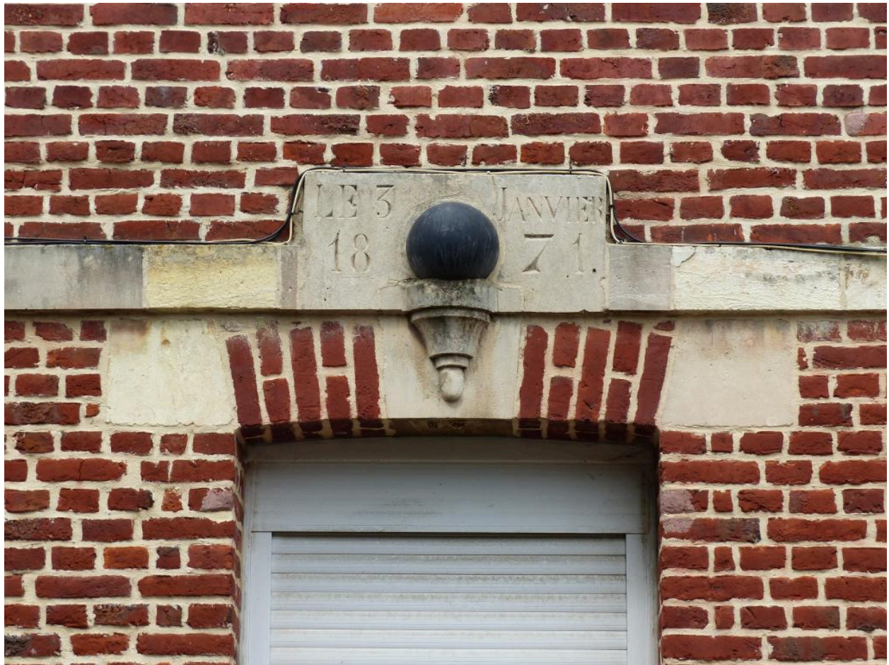
Boulet enchassé dans la façade et date portée : le 3 janvier 1871.
