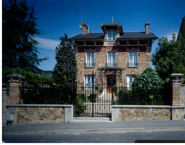
Vue d'ensemble depuis la rue. Phot. Thierry Lefébure IVR22_19930200950VA
