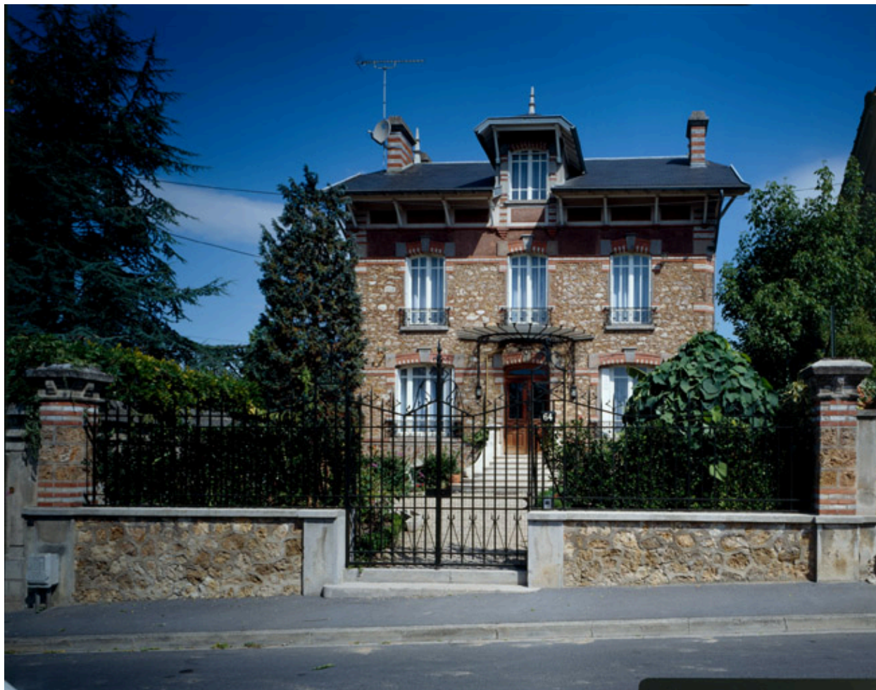
Vue d'ensemble depuis la rue.
