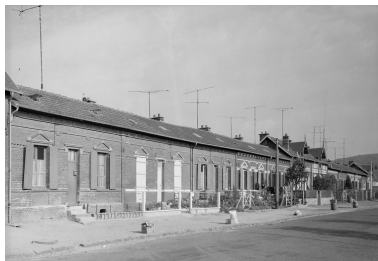
Vue générale. Phot. Fabrice Charrondière IVR22_19856001344X
