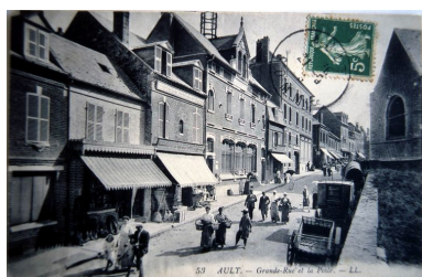
La poste, carte postale, 1er quart 20e siècle (coll. part.). Phot. Monnehay-Vulliet Marie-Laure IVR22_20058000637XAB
