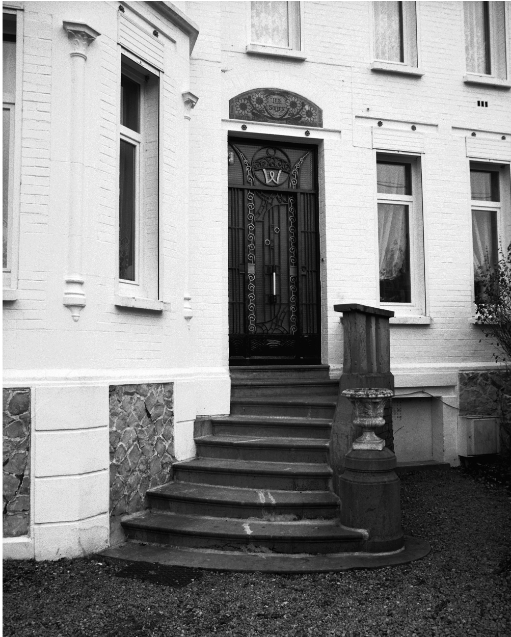
Entrée de la maison : le perron, la porte en ferronnerie et le décor de mosaïque portant la signature.
