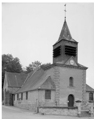
Elévation occidentale. Phot. Jean-Michel Perrin IVR22_19846001208V
