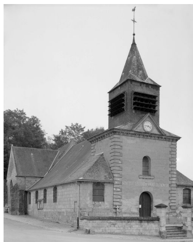
Elévation occidentale. Phot. Jean-Michel Perrin IVR22_19846001208V
