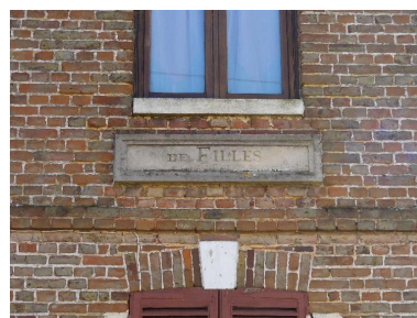
Cartouche de la travée ouest de l'ancienne école de filles ( DE FILLES) Phot. Romain Grimaud IVR22_20138005288NUCA
