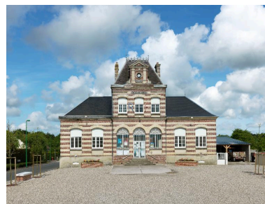
L'élévation antérieure Phot. Thierry Lefébure IVR22_20138000260NUC2A
