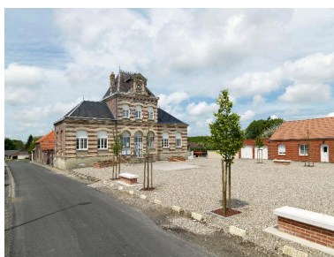
Vue générale depuis la rue Cavé Phot. Thierry Lefébure IVR22_20138000259NUC2A
