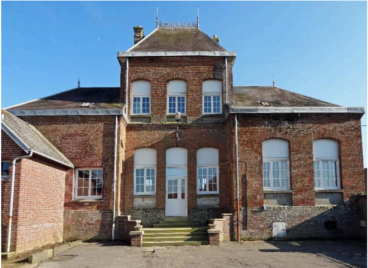
Vue générale de l'élévation postérieure
