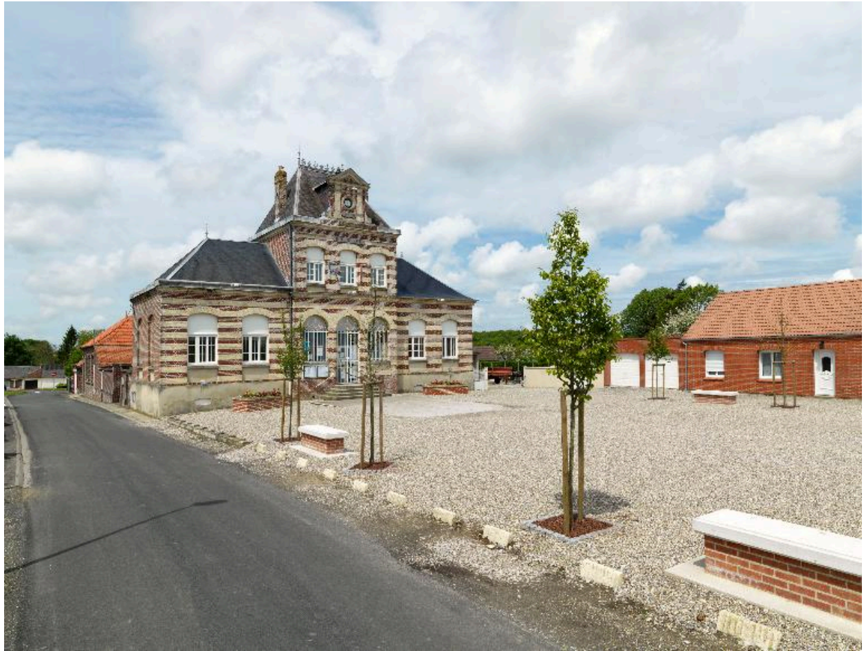
Vue générale depuis la rue Cavé
