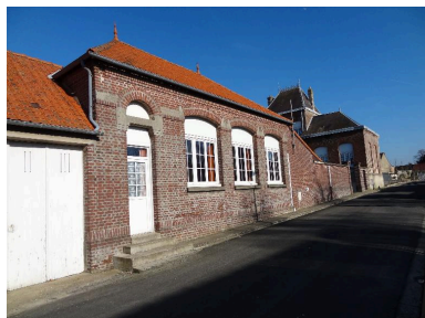
L'école des filles depuis la rue Cavé Phot. Romain Grimaud IVR22_20138005290NUC2A
