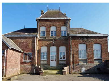
Vue générale de l'élévation postérieure Phot. Romain Grimaud IVR22_20138005291NUC2A
