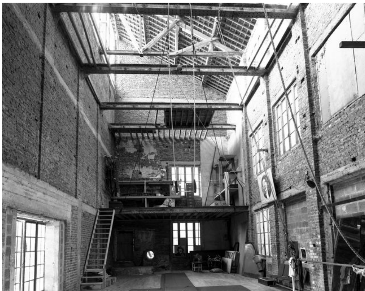
Elévation intérieure de la minoterie, transformée en salle d'entraînement.
