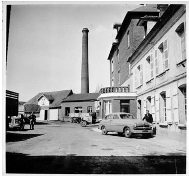
Vue d'ensemble des bâtiments et de la cheminée depuis la cour. Au premier plan, le logement patronal ou maison de meunier vers 1940.
