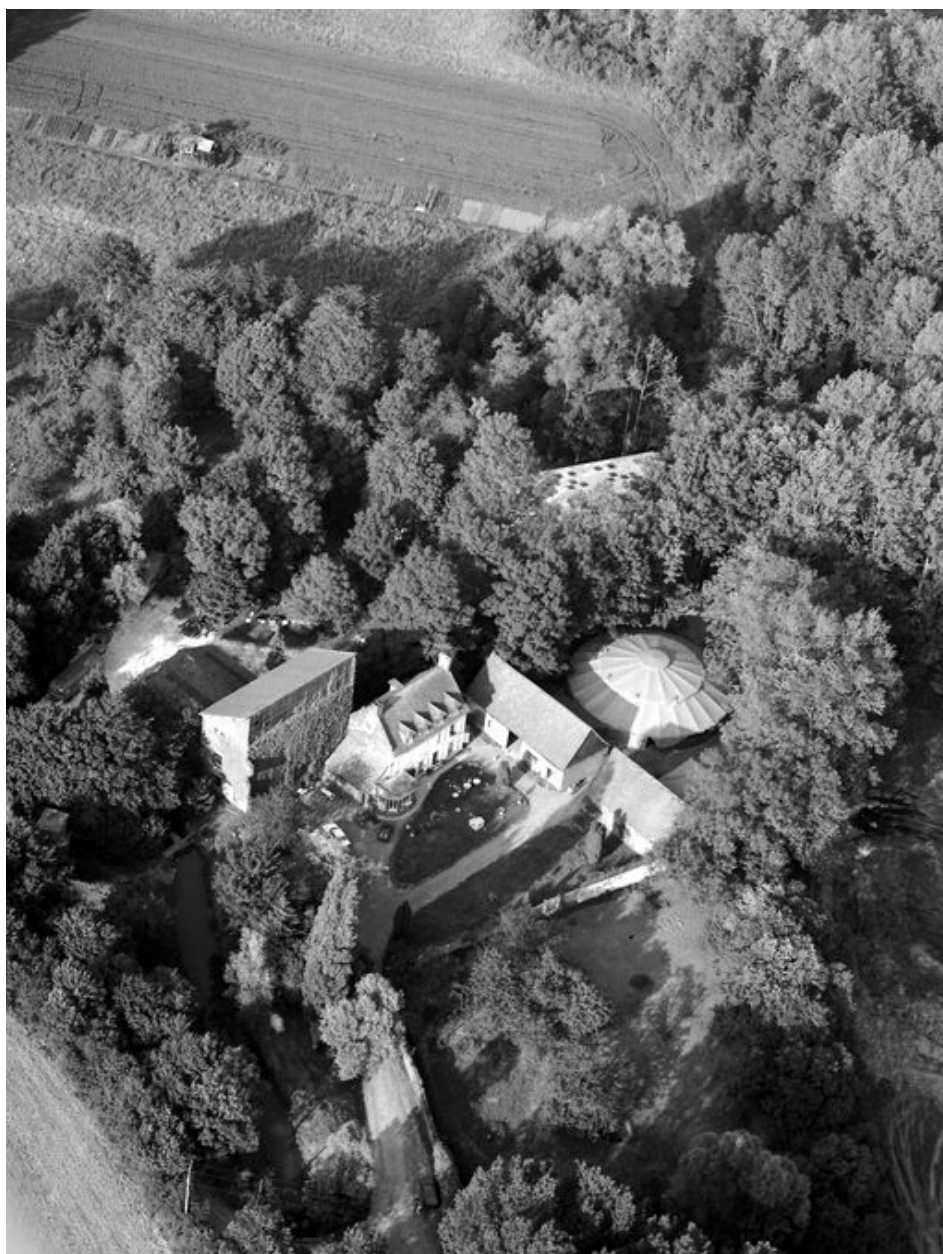
Vue aérienne du moulin de pierre en 1994.
