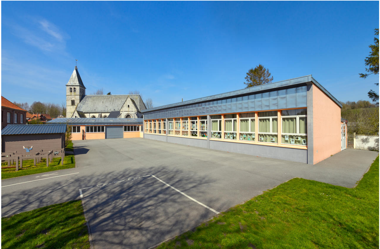
Vue générale depuis le sud.
