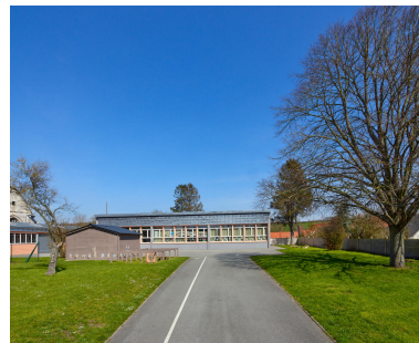
Vue de l'aile des salles de classe depuis l'entrée rue de l'église. Phot. Thierry Lefébure IVR32_20236200312NUCA
