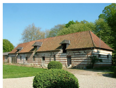
Les écuries vues de trois-quarts. Phot. Frédéric Fournis IVR22_20118001252NUCA
