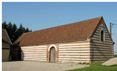
Grange. Phot. Marie-Laure Monnehay-Vulliet IVR22_20118000084NUCA
