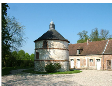
Colombier et logement. Phot. Frédéric Fournis IVR22_20118001279NUCA
