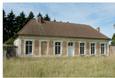
Pavillon du potager, de trois quarts. Phot. Marie-Laure Monnehay-Vulliet IVR22_20118000576NUCA
