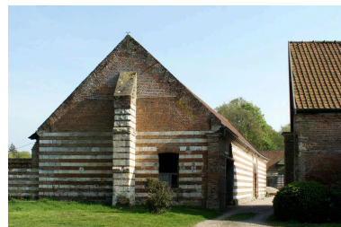
Mur-pignon et contrefort extérieurs de la grange. Phot. Marie-Laure Monnehay-Vulliet IVR22_20118000080NUCA
