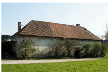
Élévation postérieure du bâtiment du potager. Phot. Marie-Laure Monnehay-Vulliet IVR22_20118000085NUCA
