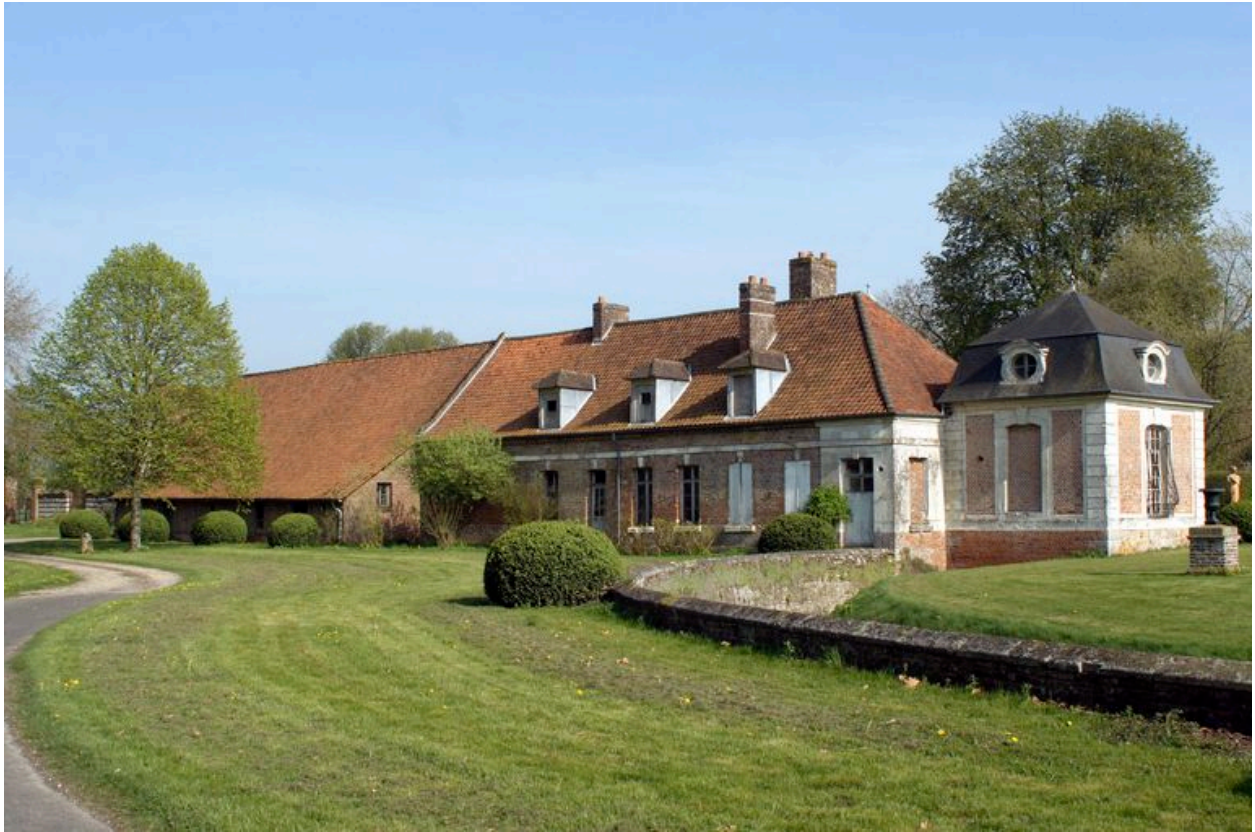
Vue extérieure des communs depuis l'esplanade.
