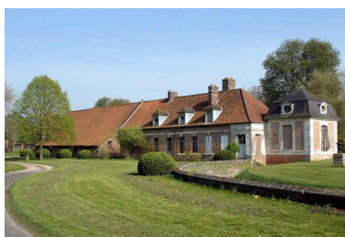
Vue extérieure des communs depuis l'esplanade. Phot. Marie-Laure Monnehay-Vulliet IVR22_20118000075NUCA
