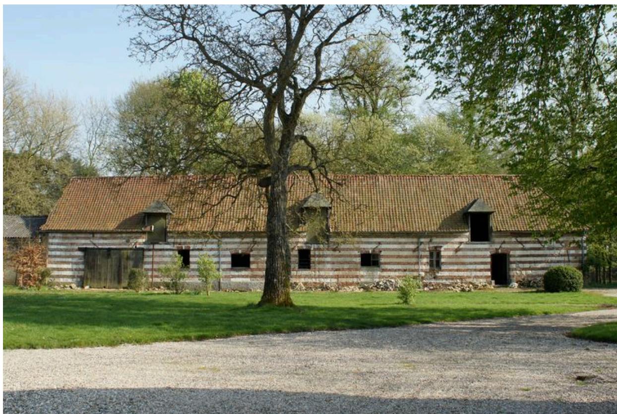
Les écuries vues de face.
