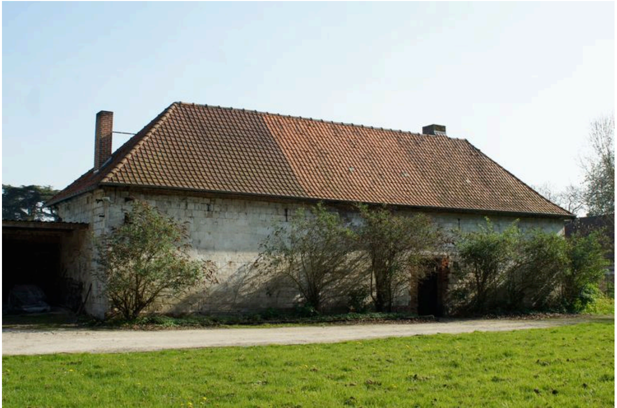
Elévation postérieure du bâtiment du potager.
