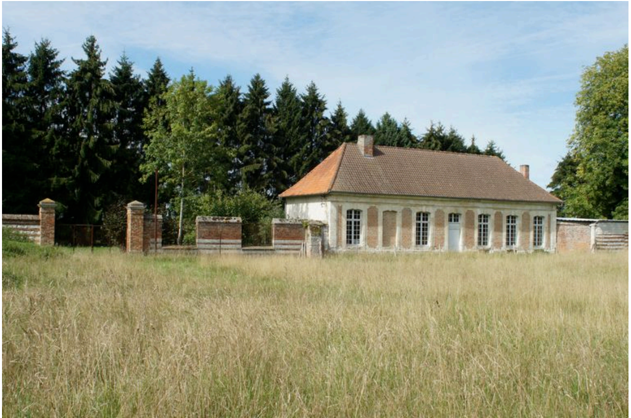
Mur de clôture et pavillon du potager.
