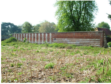
Appareil du mur d'une ancienne dépendance aujourd'hui détruite. Phot. Frédéric Fournis IVR22_20118001269NUCA
