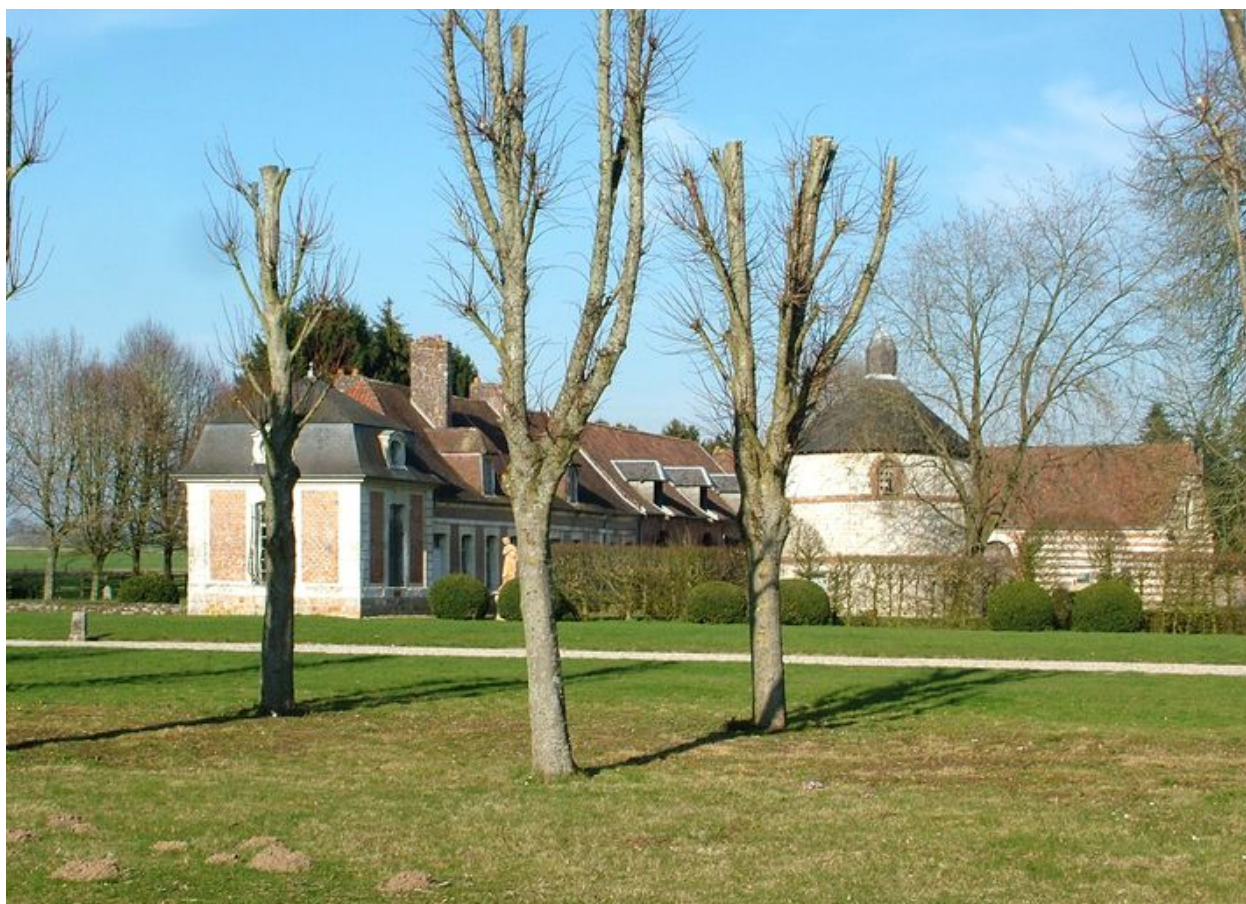
Vue générale des communs depuis la cour.
