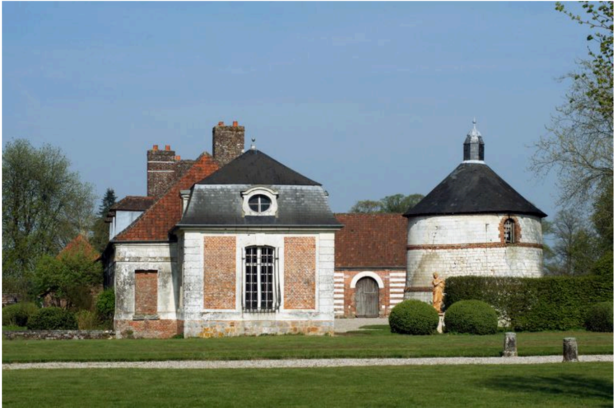
Vue partielle des communs depuis la cour.
