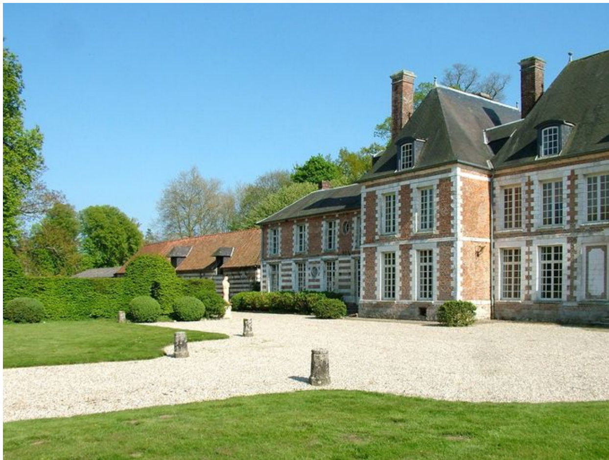
Les cuisines et les écuries prolongeant l'aile est du château.
