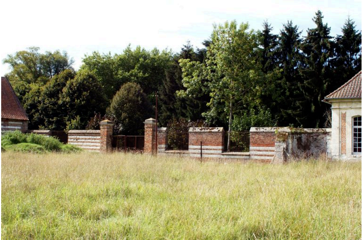
Mur de clôture du potager, intérieur.
