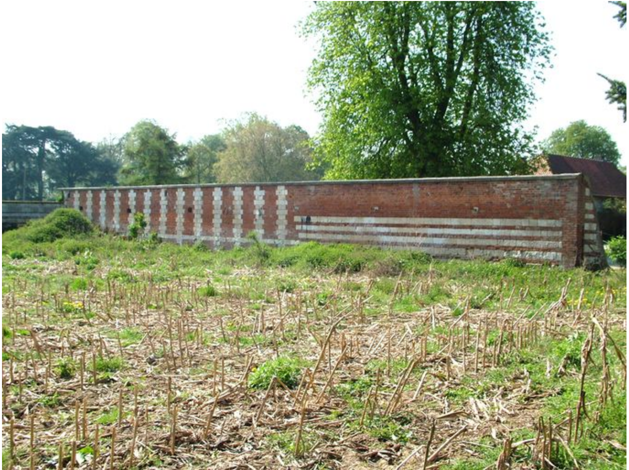
Appareil du mur d'une ancienne dépendance aujourd'hui détruite.
