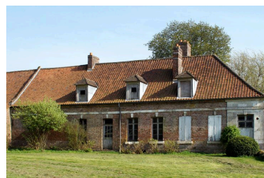
Vue extérieure du logement. Phot. Marie-Laure Monnehay-Vulliet IVR22_20118000076NUCA
