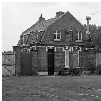
Conciergerie nord-est et entrée de l'embranchement ferroviaire. Phot. Philippe Dapvril IVR31_19885901314X
