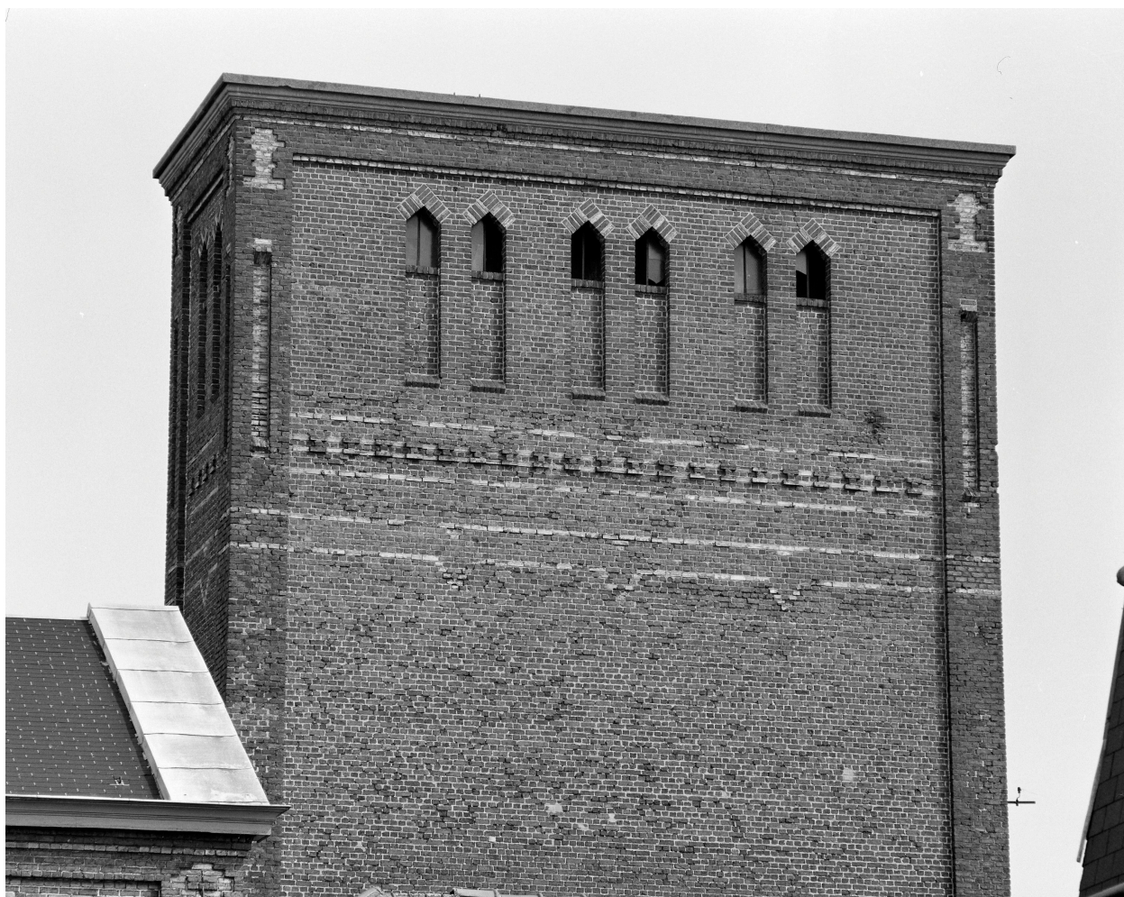
Chaufferie, détail du château d'eau.
