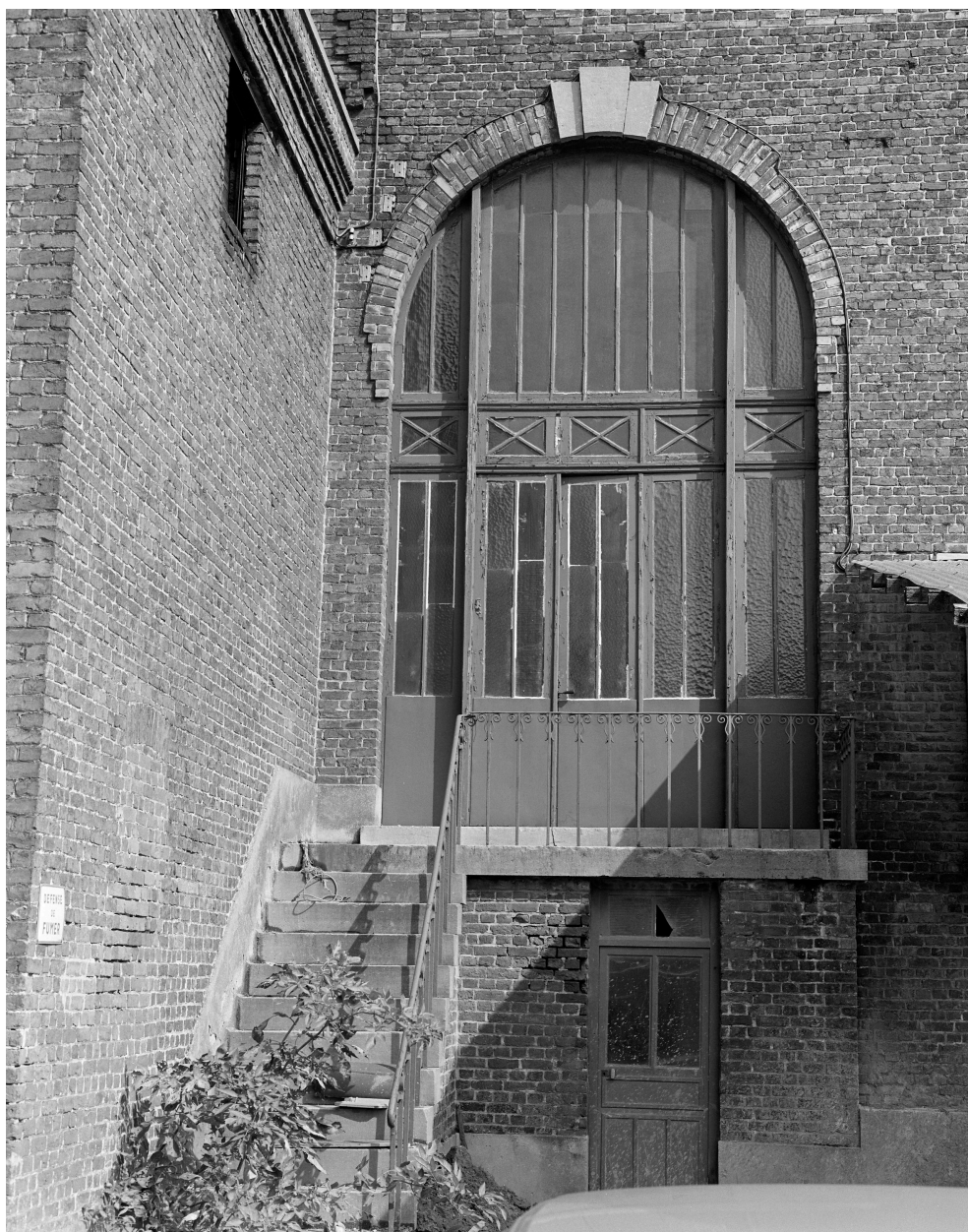
Salle des machines, entrée.
