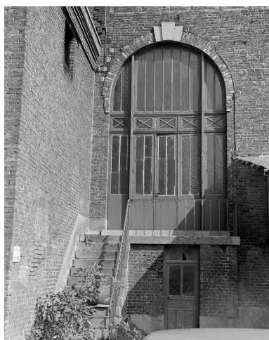
Salle des machines, entrée. Phot. Philippe Dapvril IVR31_19885901860X
