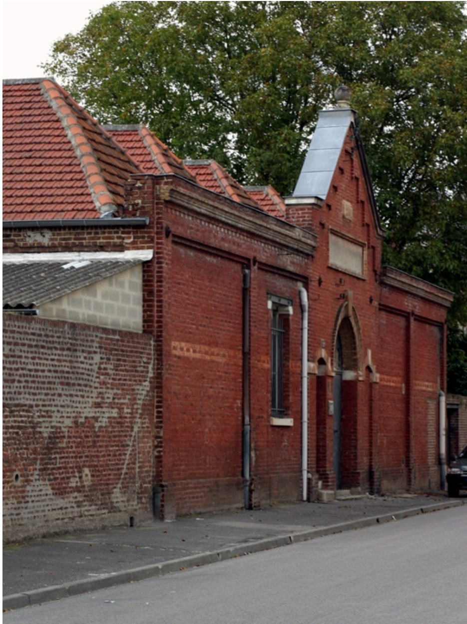
Les ateliers de 1907 : façade antérieure.
