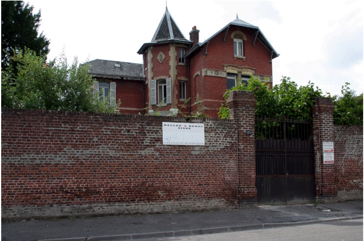
L'ancien logement patronal.
