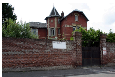
L'ancien logement patronal. Phot. Frédéric Pillet IVR22_20040200908NUCA
