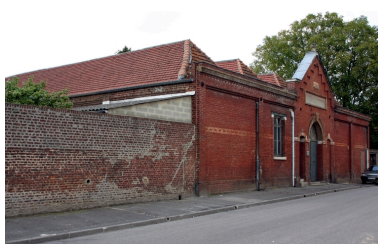
Les ateliers construits en 1907. Phot. Frédéric Pillet IVR22_20040200909NUCA
