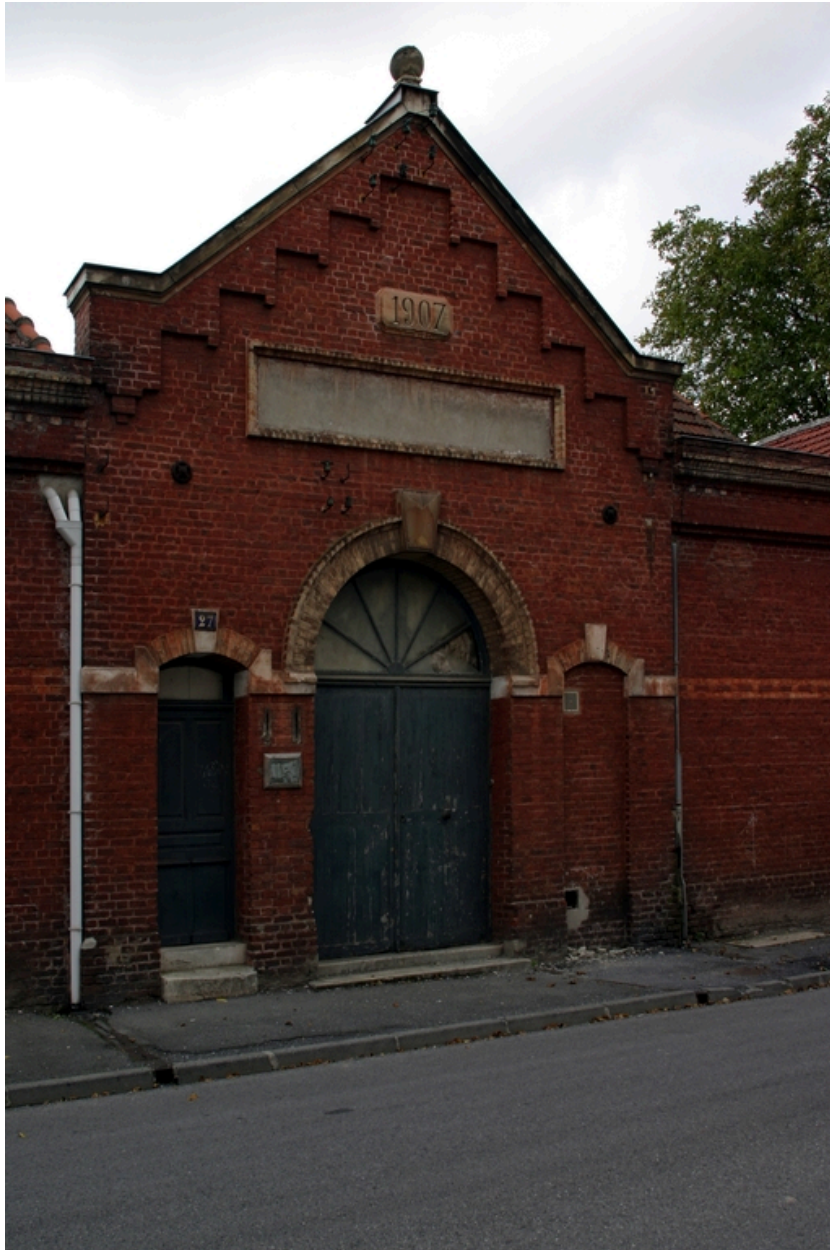
Les ateliers de 1907 : détail de la façade antérieure.
