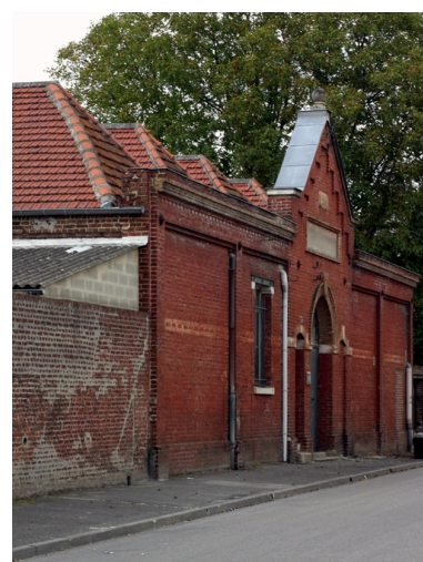
Les ateliers de 1907 : façade antérieure. Phot. Frédéric Pillet IVR22_20040200910NUCA
