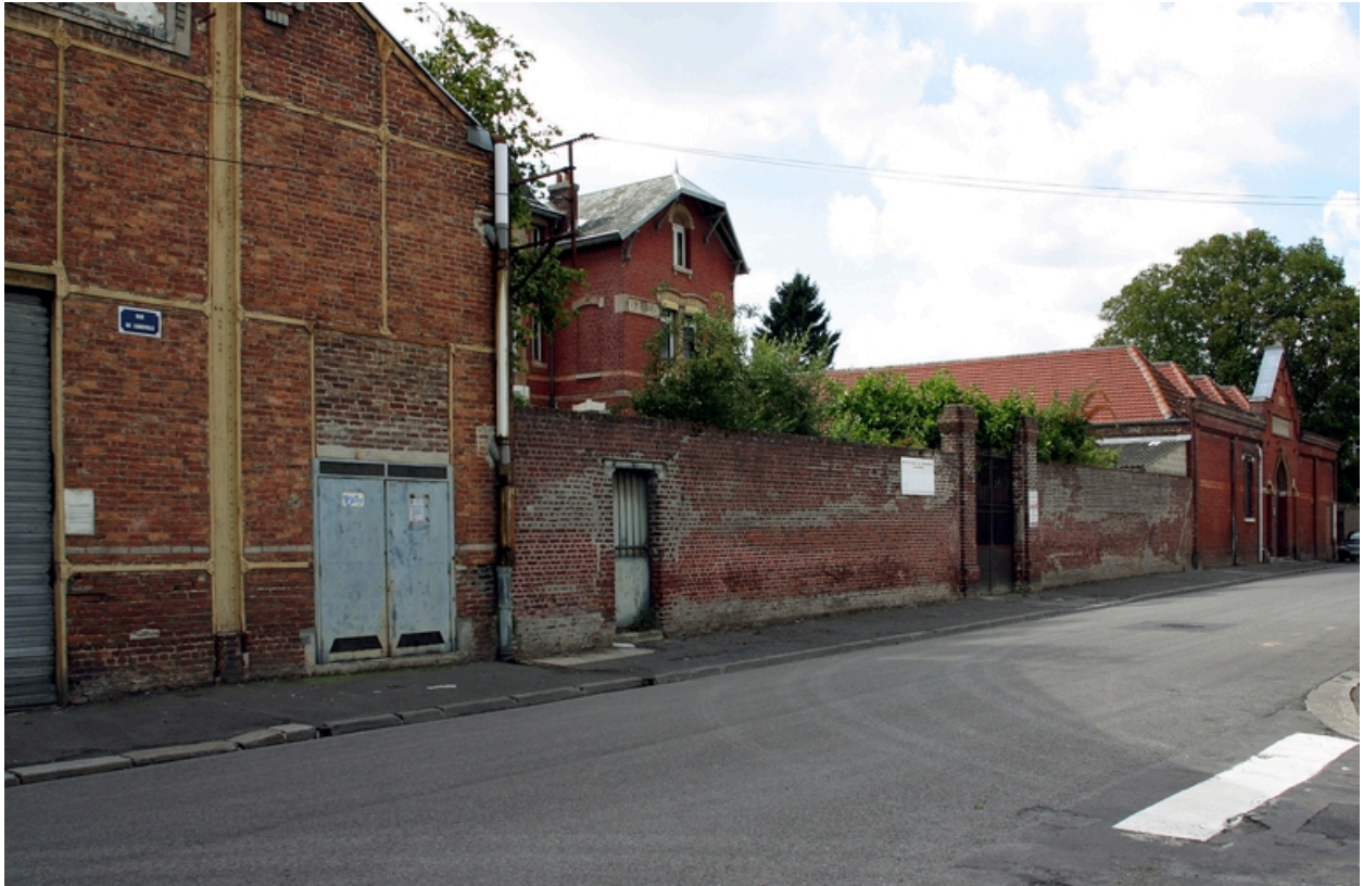
Vue générale du site (à droite, l'ancien atelier de la Société de Constructions Métalliques de Remicourt, aujourd'hui intégré à l'usine).
