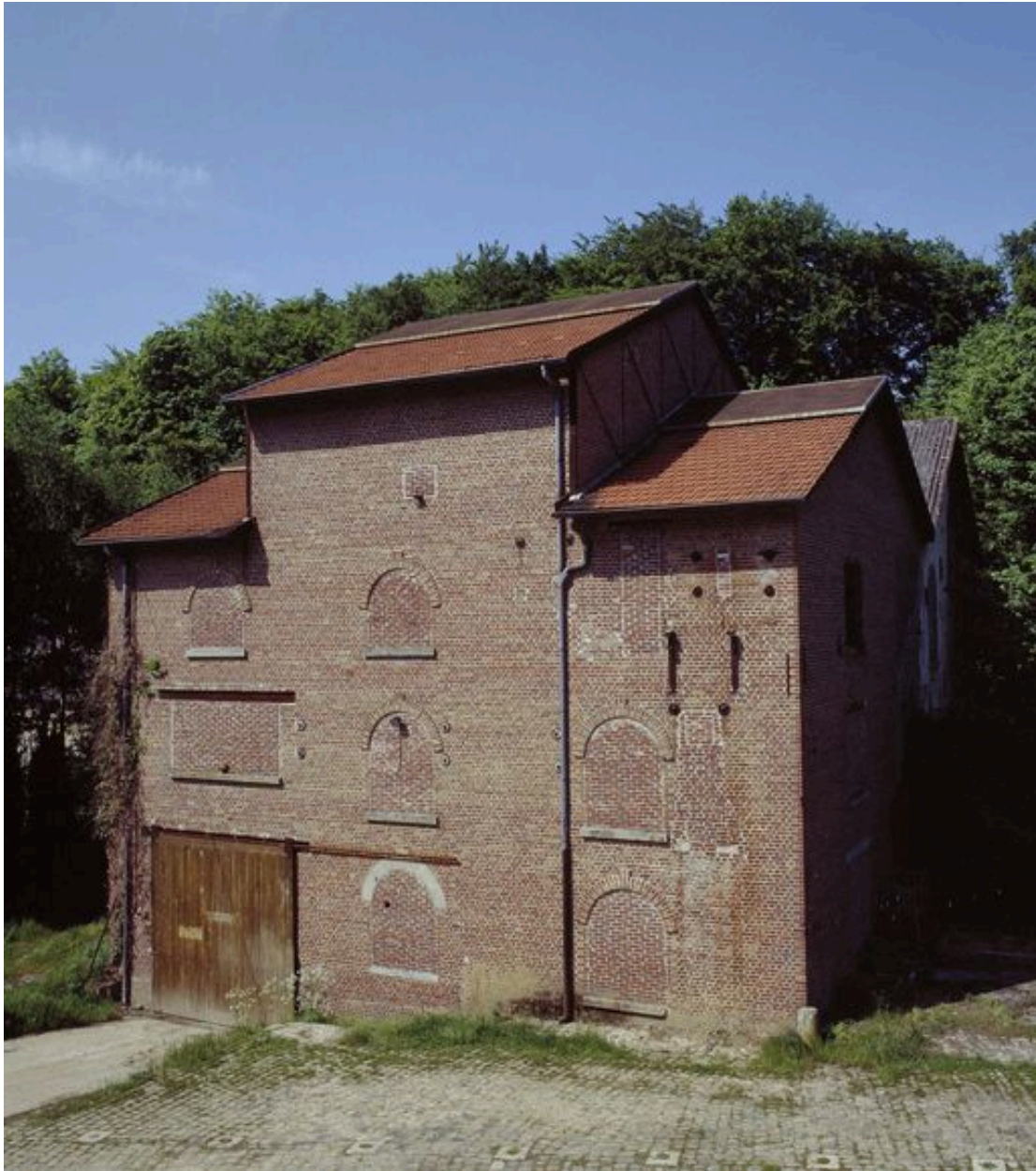
L'ancienne distillerie, façade sud.
