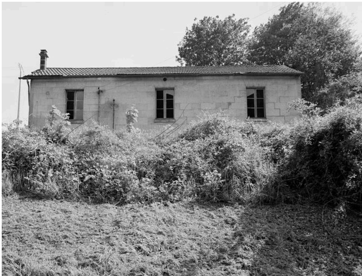
Logement d'ouvriers : façade nord.
