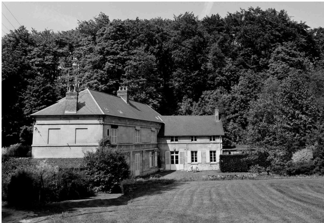
Logement patronal, angle sud-est.
