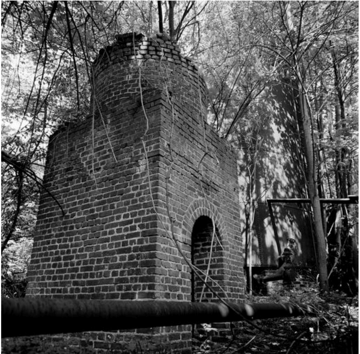
Cheminée d'usine : socle.
