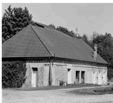
Bureau, façade nord. Phot. Patrick Glotain IVR22_19936000567X
