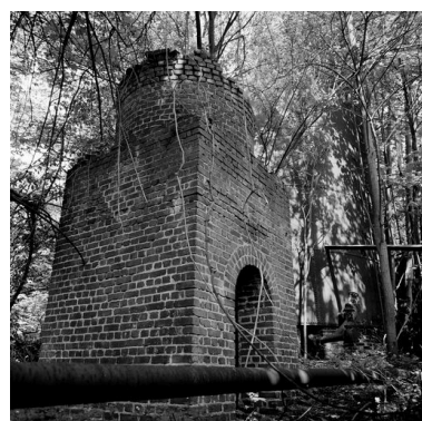
Cheminée d'usine : socle. Phot. Patrick Glotain IVR22_19936000570X
