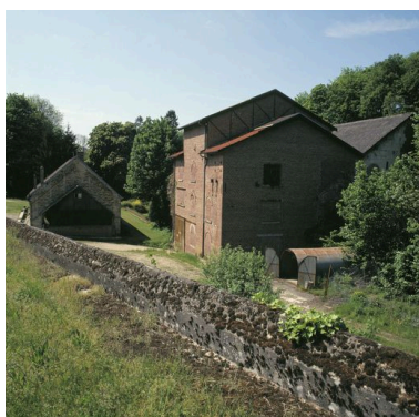
Bâtiment de l'ancienne distillerie d'alcool, vue d'ensemble sud. Phot. Patrick Glotain IVR22_19936001825XA
