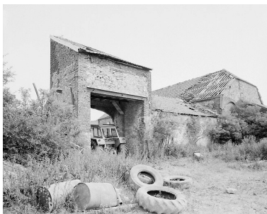
Vue de l'élévation postérieure du pigeonnier-porche de la ferme située 11 rue d'Avesnes. Phot. Pierre Thibaut IVR31_20055900646V
