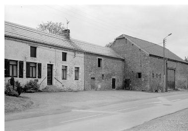
Vue de la ferme située 7 rue d'Avesnes. Phot. Pierre Thibaut IVR31_20055900627X
