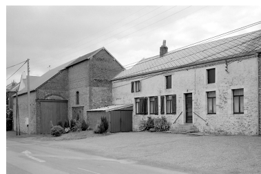
Vue de la ferme située 7 rue d'Avesnes Phot. Pierre Thibaut IVR31_20055900626X
