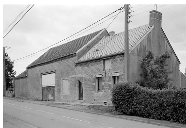
Vue générale de la ferme située 3 Grand Rue. Phot. Pierre Thibaut IVR31_20055900629X
