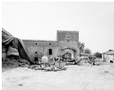
Vue du pigeonnier-porche de la ferme située 11 rue d'Avesnes. Phot. Pierre Thibaut IVR31_20055900647V
