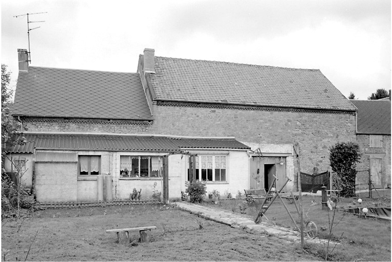
Vue de l'élévation postérieure de la ferme située 3 Grand Rue.
