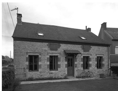
Vue générale de la maison située 55 rue Pasteur. Phot. Pierre Thibaut IVR31_20055904316V
