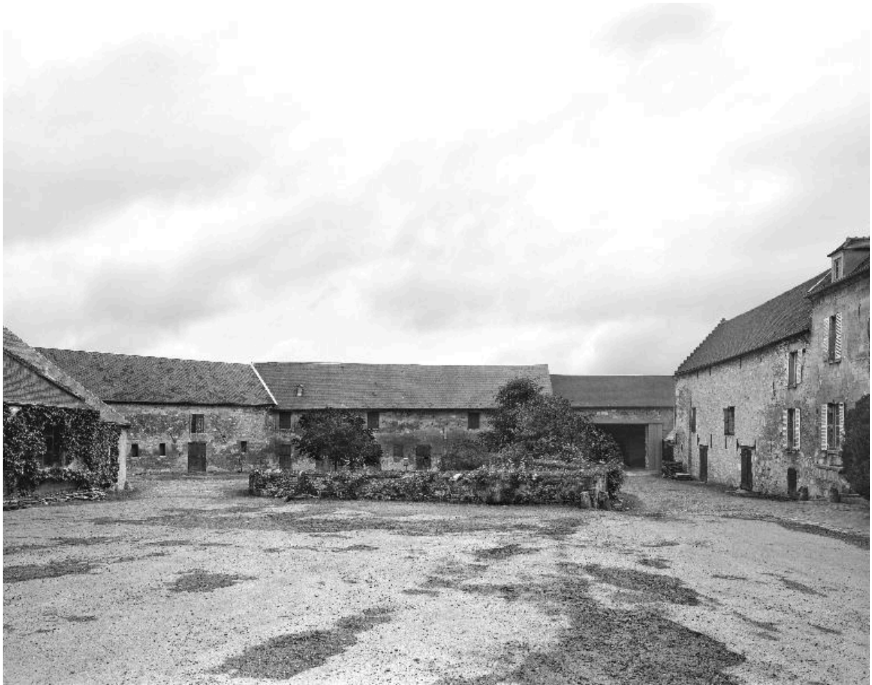
Vue des bâtiments agricoles qui bordent la cour de l'est au nord.
