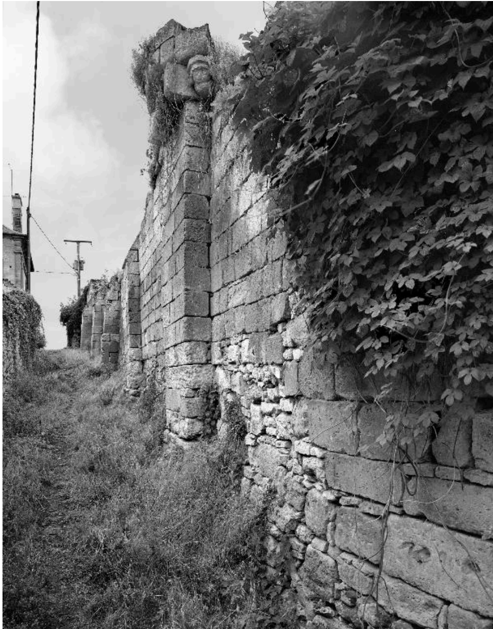
Vue du mur d'enceinte qui borde la "sente rurale des Escaliers".
