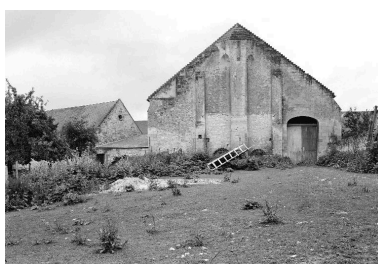
Vue de l'élévation nord-ouest de la grange.
