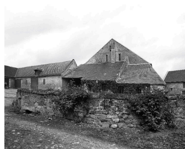
Vue du pignon sud-est de la grange et des étables attenantes.
