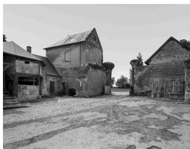
Vue de l'entrée de la ferme, depuis la cour. Phot. Thierry Lefébure IVR22_19900200879V
