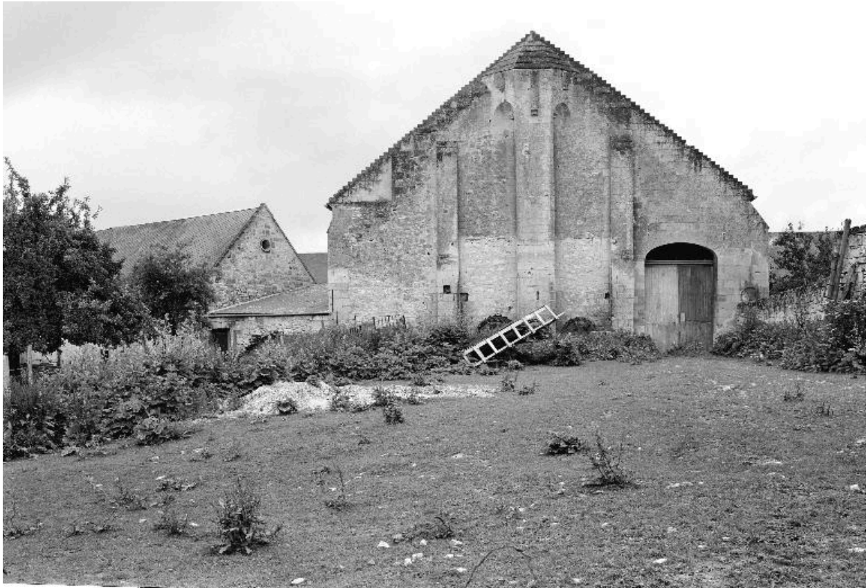
Vue de l'élévation nord-ouest de la grange.
