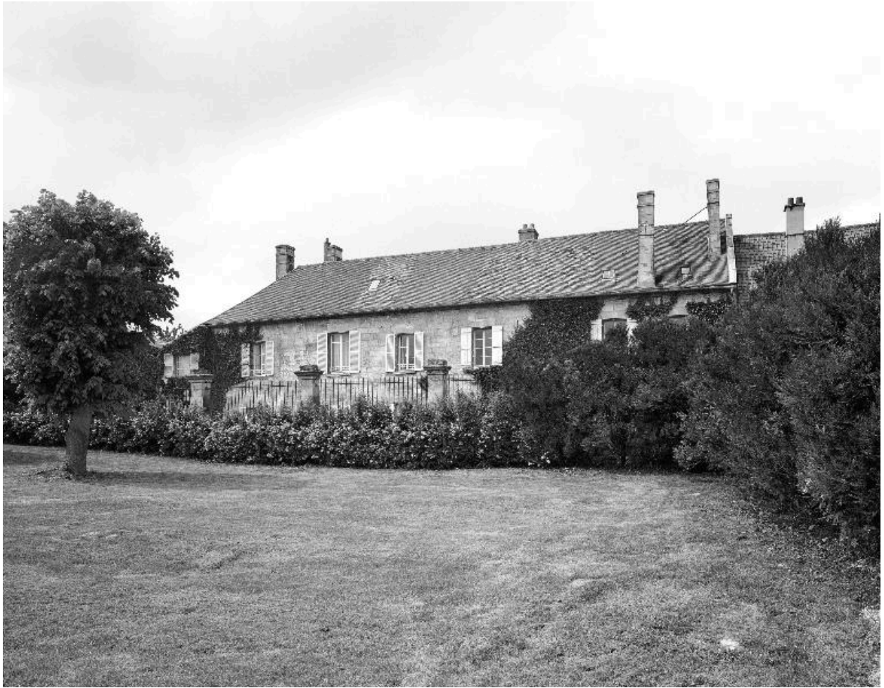
Logis : vue de l'élévation extérieure sud-est.
