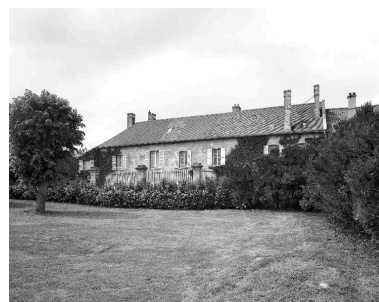
Logis : vue de l'élévation extérieure sud-est. Phot. Thierry Lefébure IVR22_19900200890V
