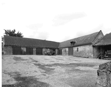
Vue de l'élévation sur cour des étables ouest.
