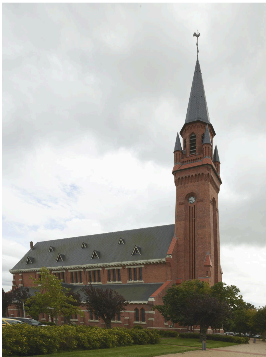
Vue générale, prise depuis le sud.
