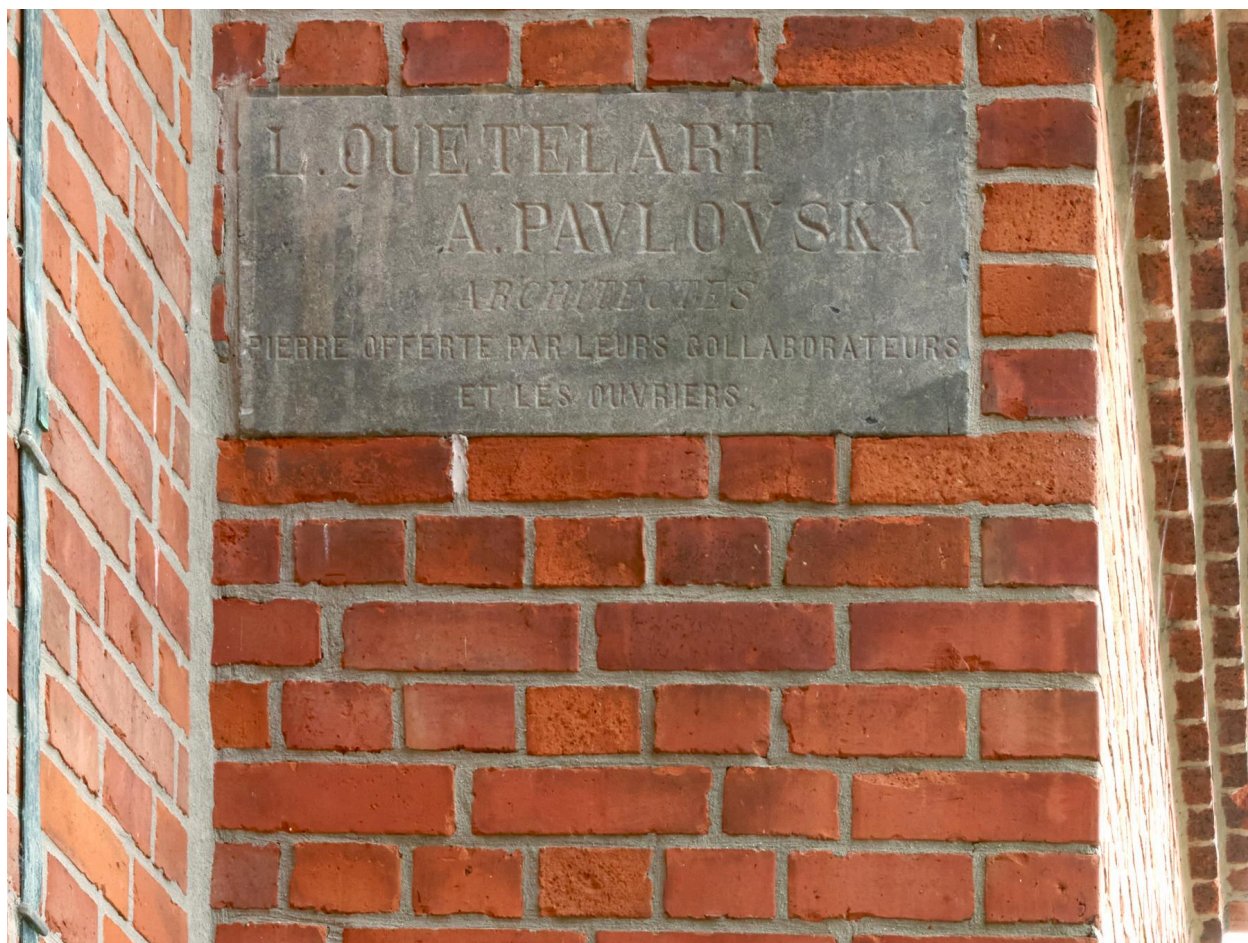
Plaque d'architecte (pierre) : "L. QUETELART / A. PAVLOSKY / ARCHITECTES / PIERRE OFFERTE PAR LEURS COLLABORATEURS / ET OUVRIERS". Localisée sur l'intrados du porche nord.
