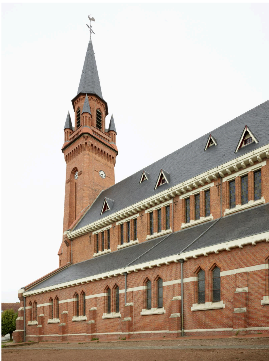
Vue générale de la façade sud.
