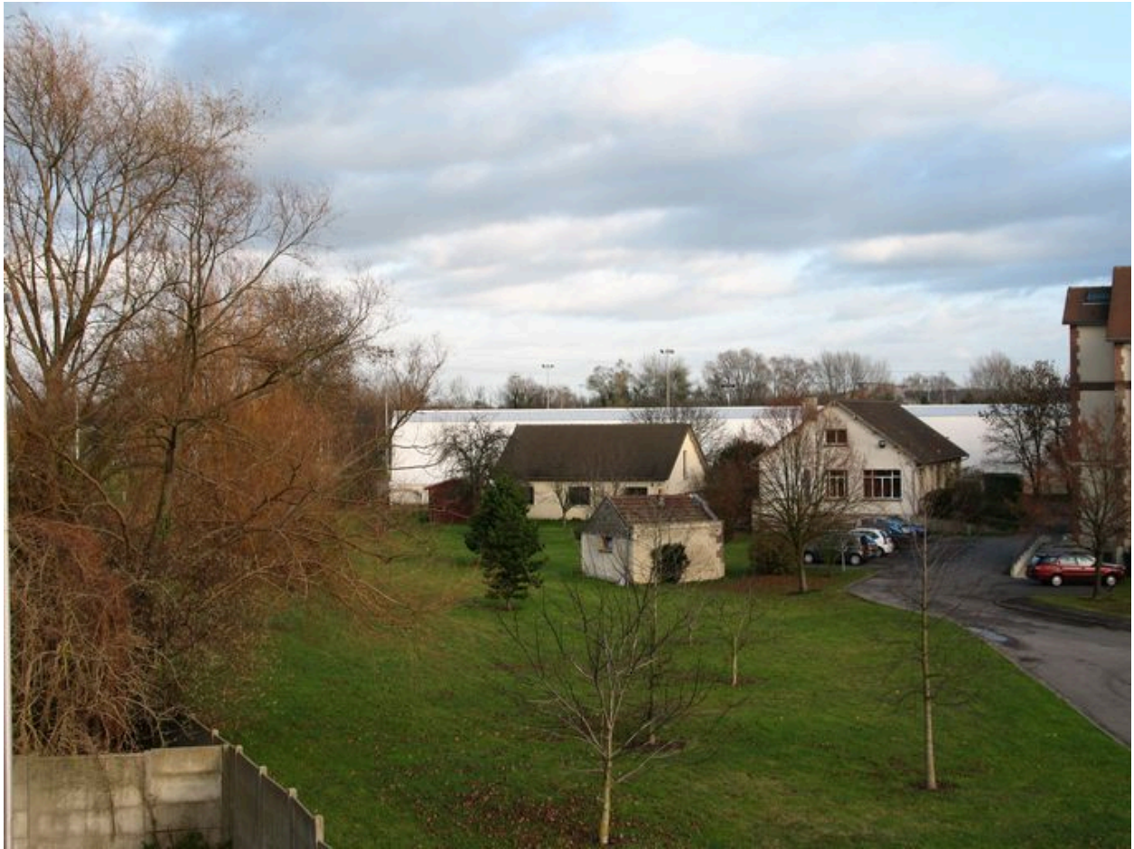
Dépendances de l'ancien moulin autour de la maison de retraite.
