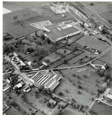
Vue aérienne des usines depuis le sud-est Phot. Phot'R IVR22_19888001489P
