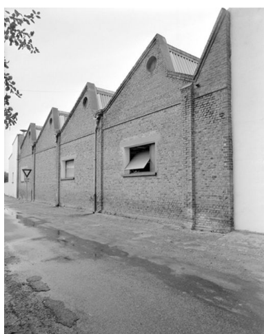
Atelier de fabrication, flanc est Phot. Thierry Lefébure IVR22_19888001009X
