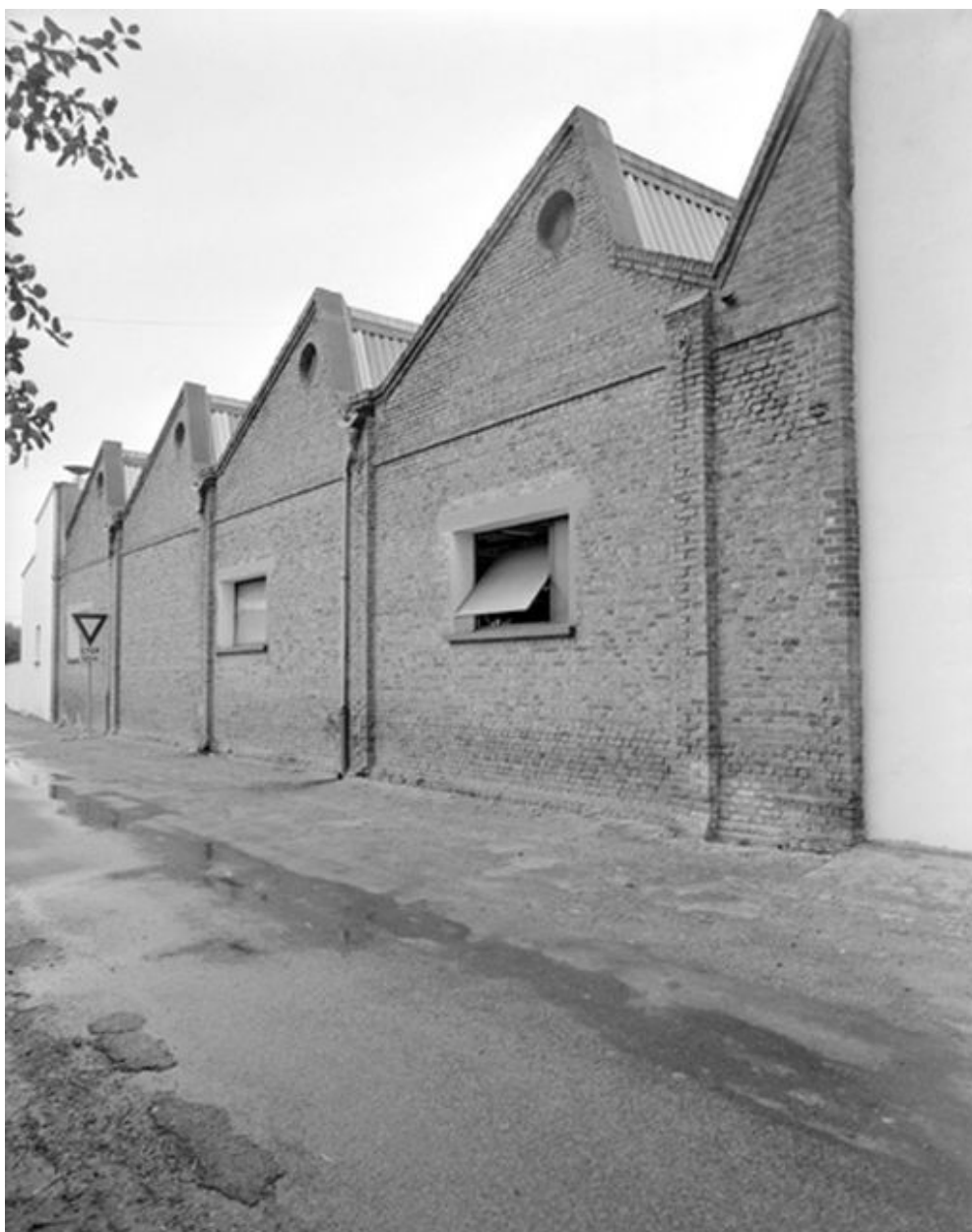
Atelier de fabrication, flanc est
