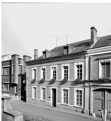
Vue de la façade de la maison située rue Chantraine (N°165). Phot. Thierry Lefébure IVR22_20020200854X
