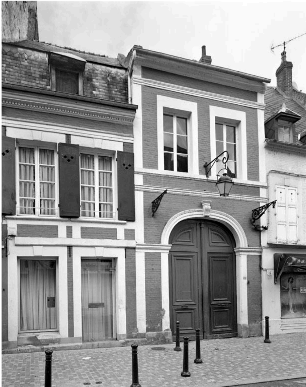
Vue de la façade de la maison située rue Camille-Desmoulins (N°133).
