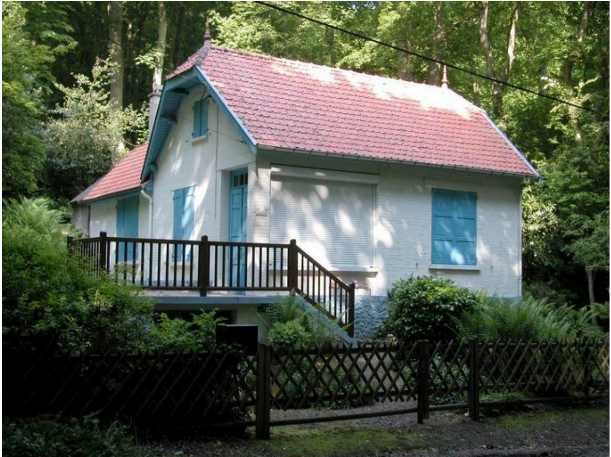
Vue d'ensemble depuis la rue.
