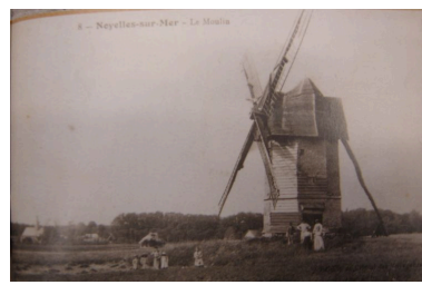
Vue du moulin à vent de Noyelles au début du 20e siècle.
