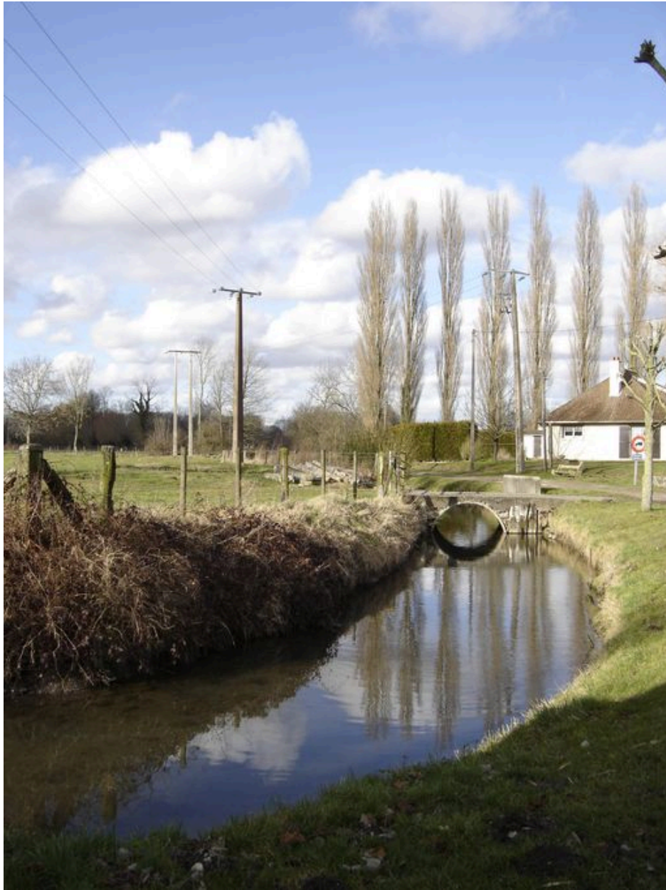
Vue des canaux au bout de la rue du Général Leclerc illustrant l'importance de l'eau à Noyelles-sur-Mer.
