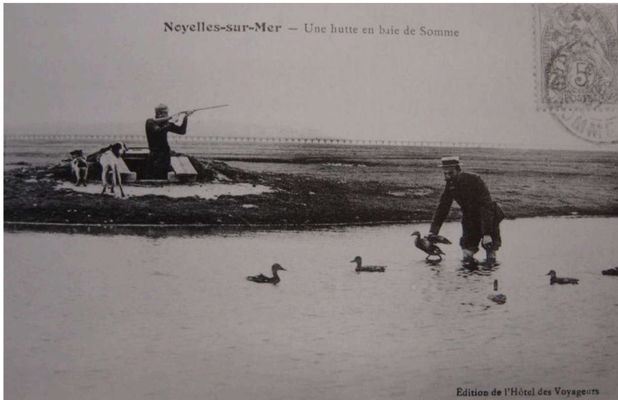
Vue de l'estacade en arrière-plan.
