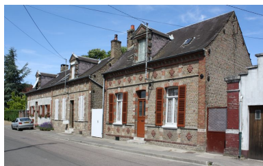
Vue générale. Phot. Bertrand Fournier IVR22_20098005024NUCA
