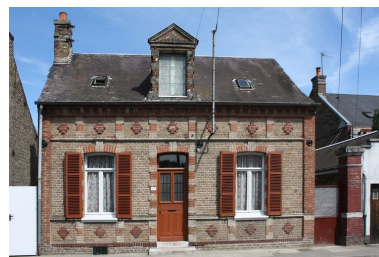
Maison, 24 rue Marius-Sire. Elévation sur rue. Phot. Bertrand Fournier IVR22_20098005026NUCA
