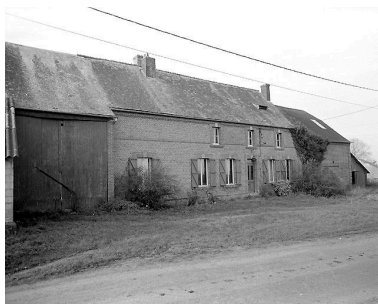
Façade est du logis, avec l'entrée de la grange traversante. Phot. Laurent Jumel IVR22_19970202208X
