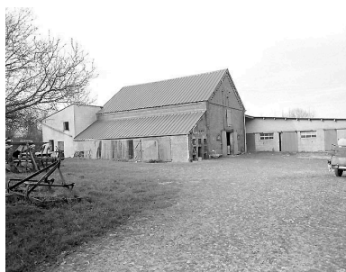
Vue de la cour intérieure : grange-étable. Phot. Laurent Jumel IVR22_19970202207X
