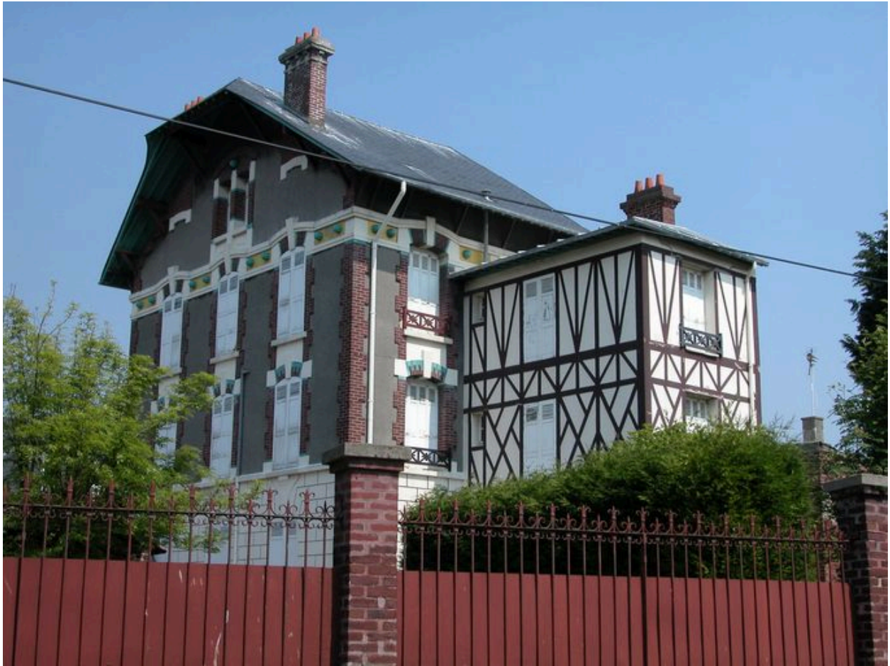
Vue d'ensemble depuis la rue Mennessier.
