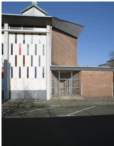
Flanc droit et entrée de la sacristie. Phot. Pierre Thibaut IVR31_20155900883NUCA
