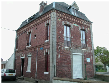
Vue depuis la rue du Mont-Roti. Phot. Elisabeth Justome IVR22_20058003618NUCA
