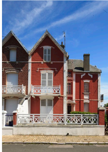
Façade sud (détail). Phot. Hubert Bouvet IVR31_20136200161NUCA
