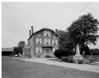
Vue d'ensemble, depuis le sud-est. Phot. Thierry Lefébure IVR22_19910202000V
