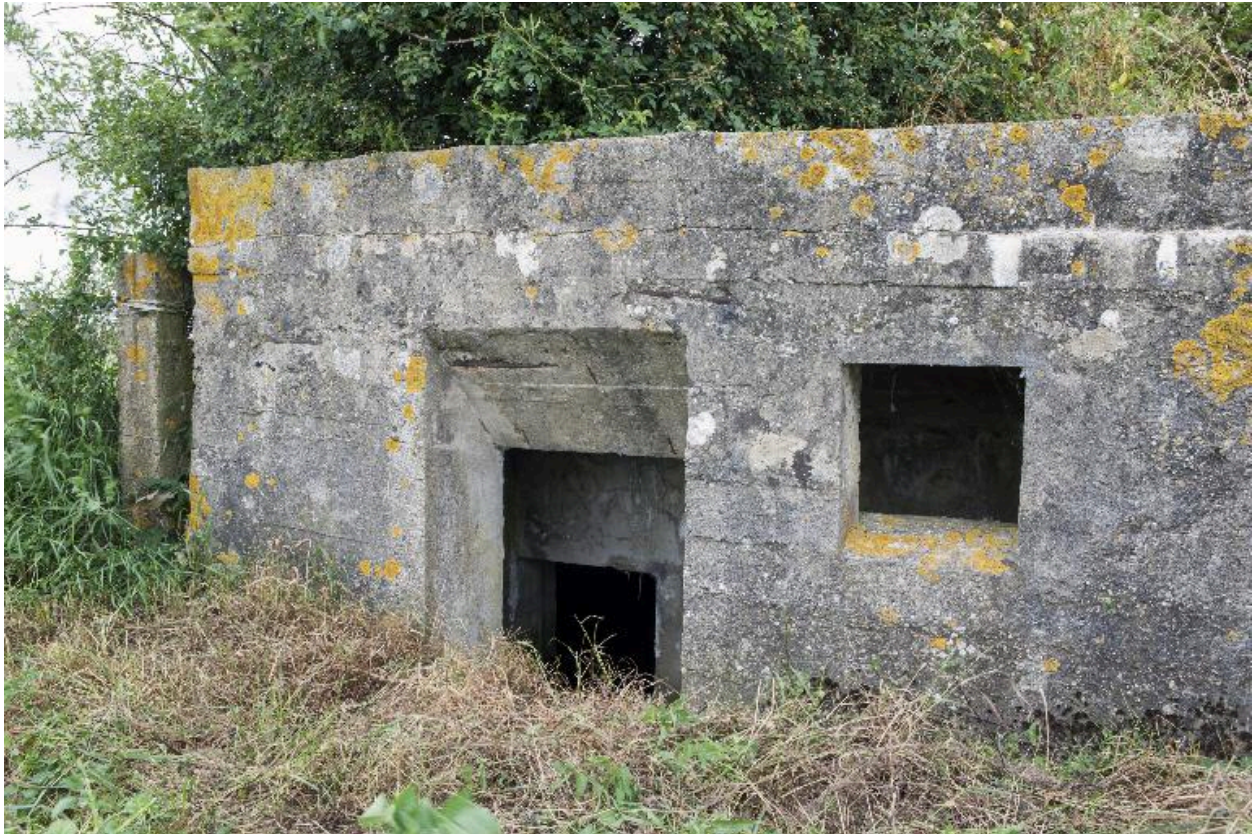
Entrée vers le nord-ouest. Accès au couloir et à la salle ouest de l'abri
