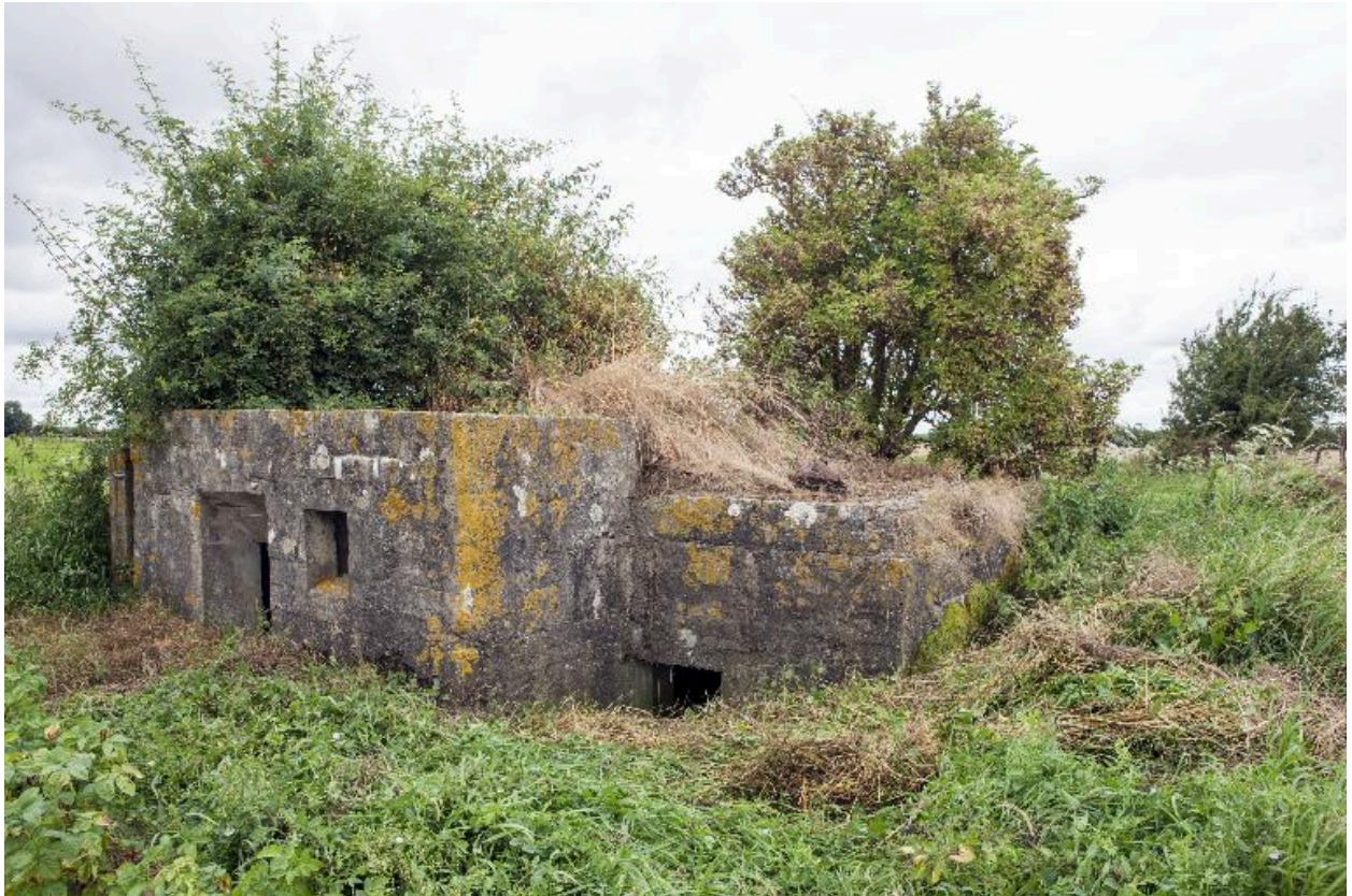
Vue de trois-quarts vers le nord-ouest. A gauche l'entrée de la casemate, à droite, la soute à munitions (?)
