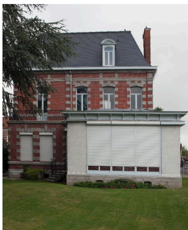
Vue générale de la façade postérieure. Phot. Pierre Thibaut IVR31_20125901944NUCA
