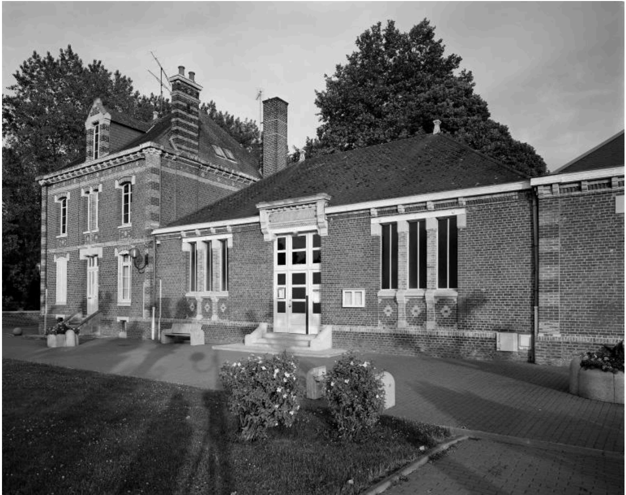
Vue du pavillon, qui est ajouté après 1886, par Achille Grebel, pour abriter l'école enfantine.
