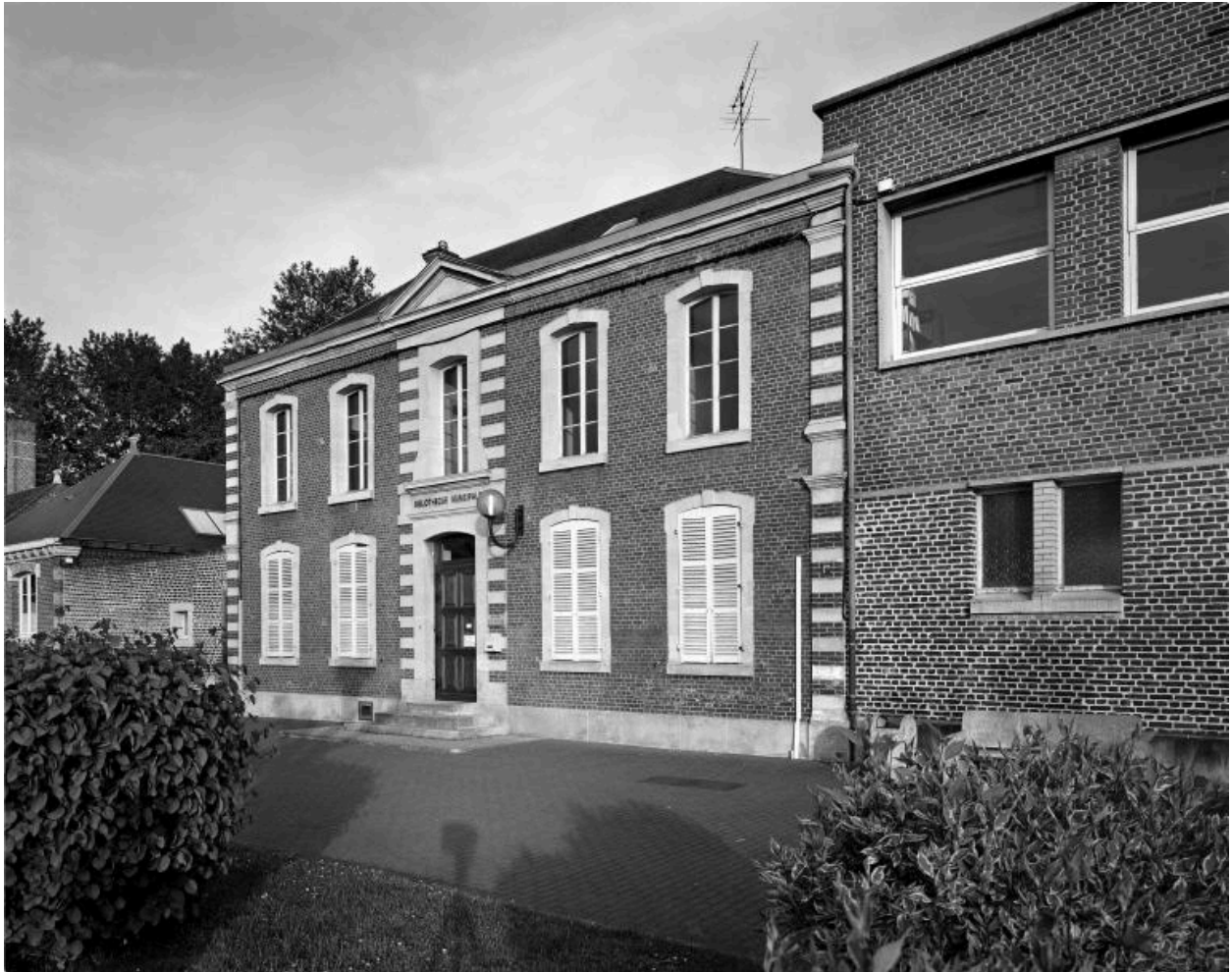
Vue du pavillon latéral construit pour l'école des filles, abritant aujourd'hui la bibliothèque municipale.
