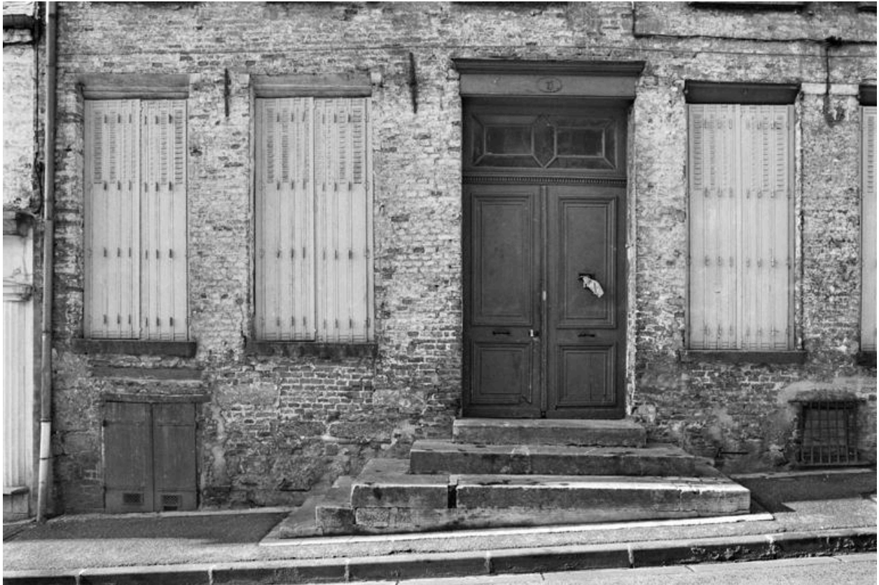
Détail du rez-de-chaussée.
