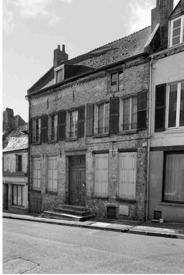
Vue de l'élévation sur rue. Phot. Pierre-Yves Brest IVR22_19990207142Z
