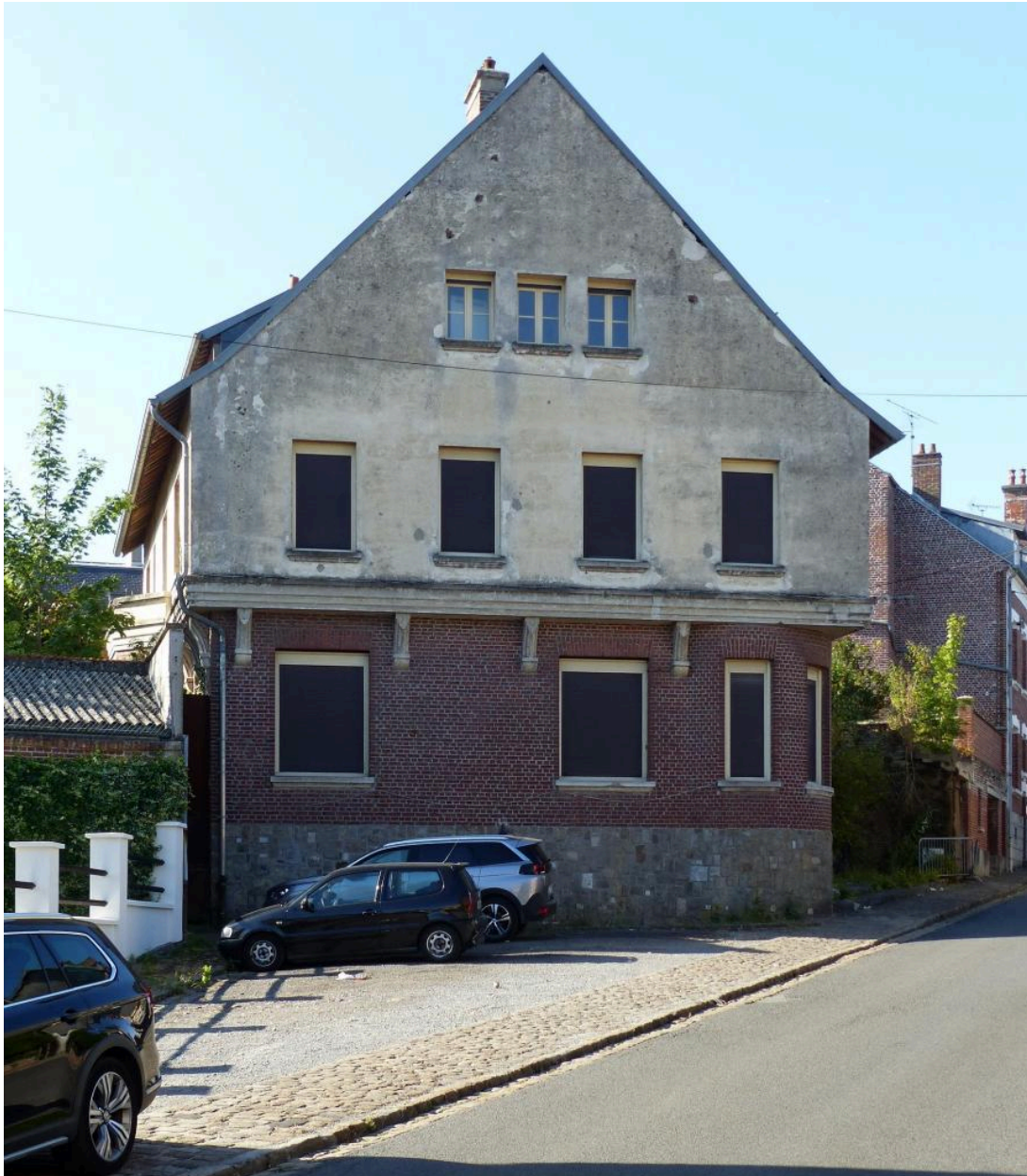
Vue de la façade nord.
