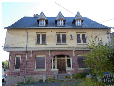
Vue de la façade ouest sur rue. Phot. Isabelle Barbedor IVR32_20188005192NUCA
