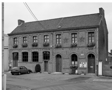
Vue générale de face. Phot. Philippe Dapvril IVR31_20045900495X
