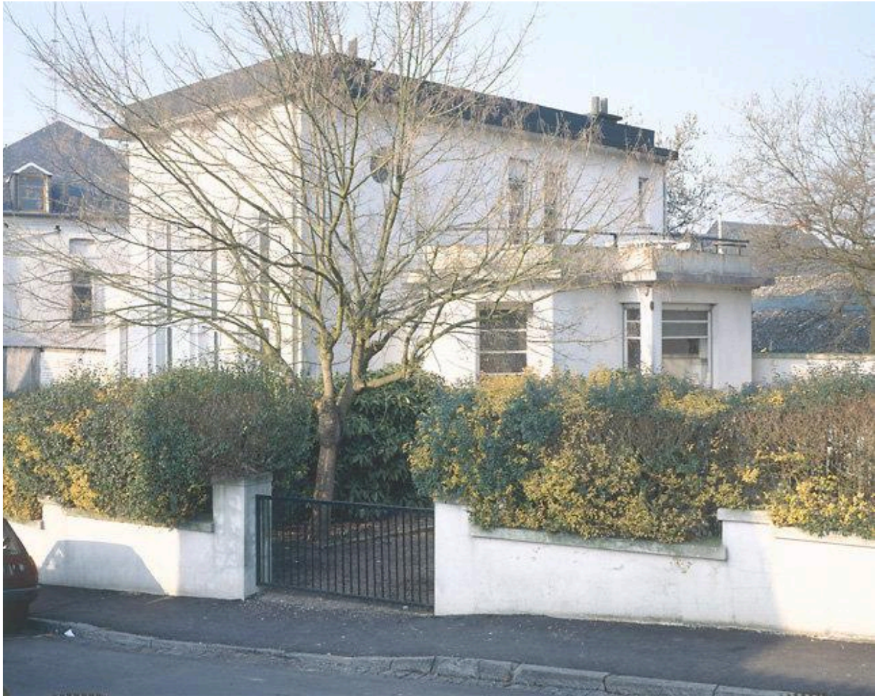
Vue de trois quarts vers le nord.
