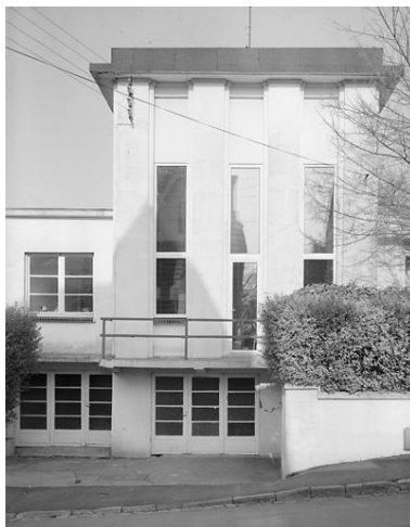
Élévation antérieure sur rue. Phot. Olivier Marlard IVR31_19935900467X
