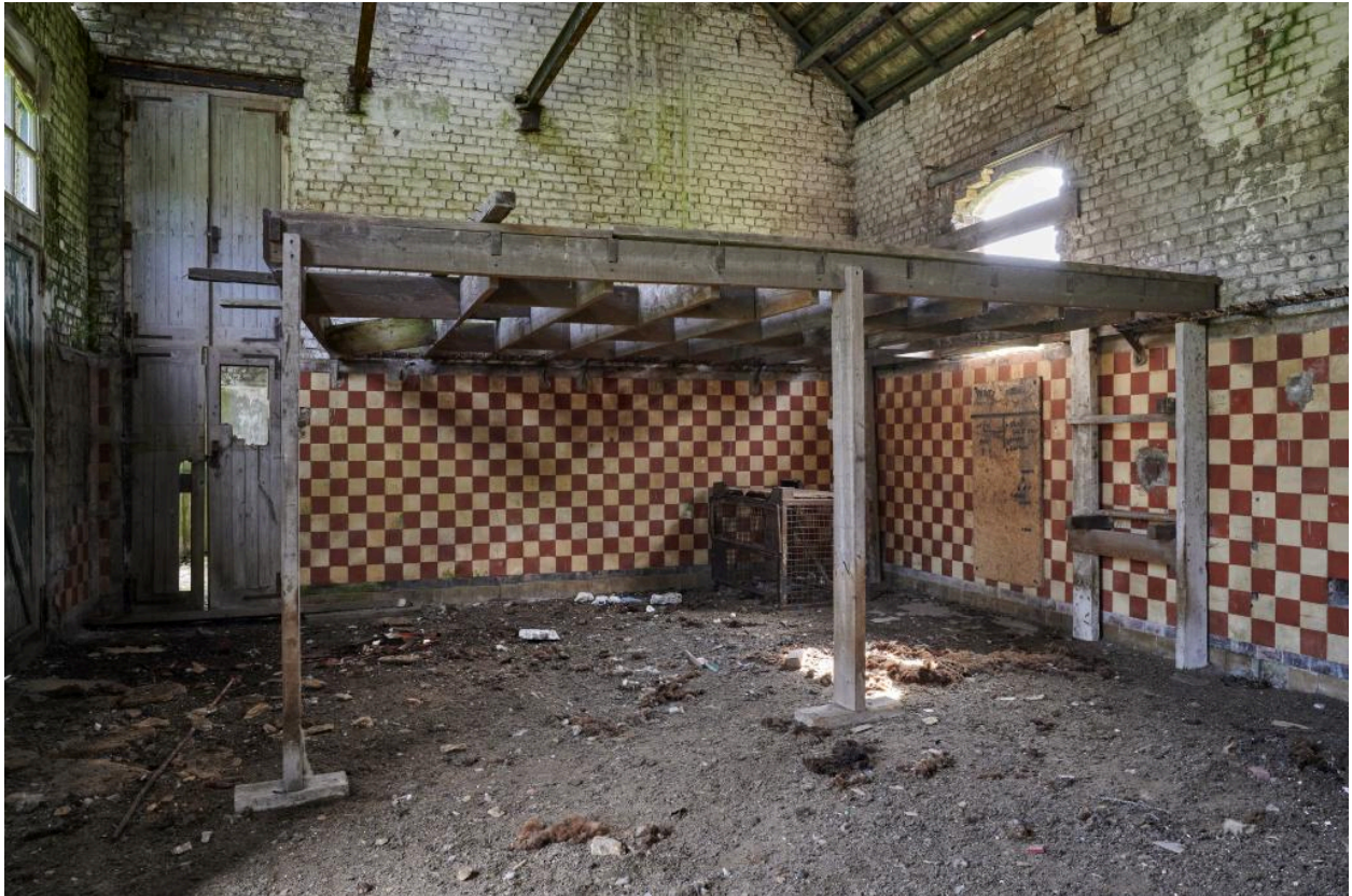
Vue générale intérieure de l'abattoir.
