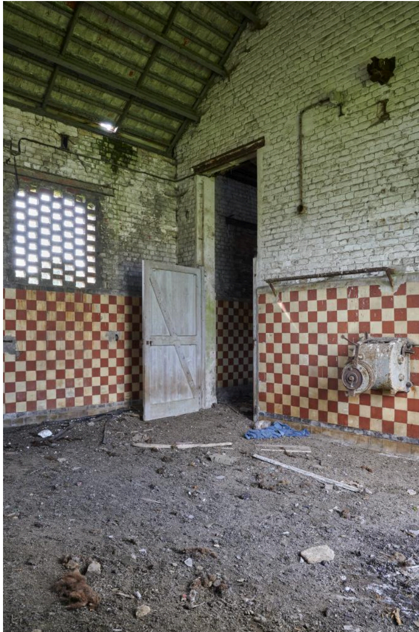
Porte d'entrée de la salle d'abattage.
