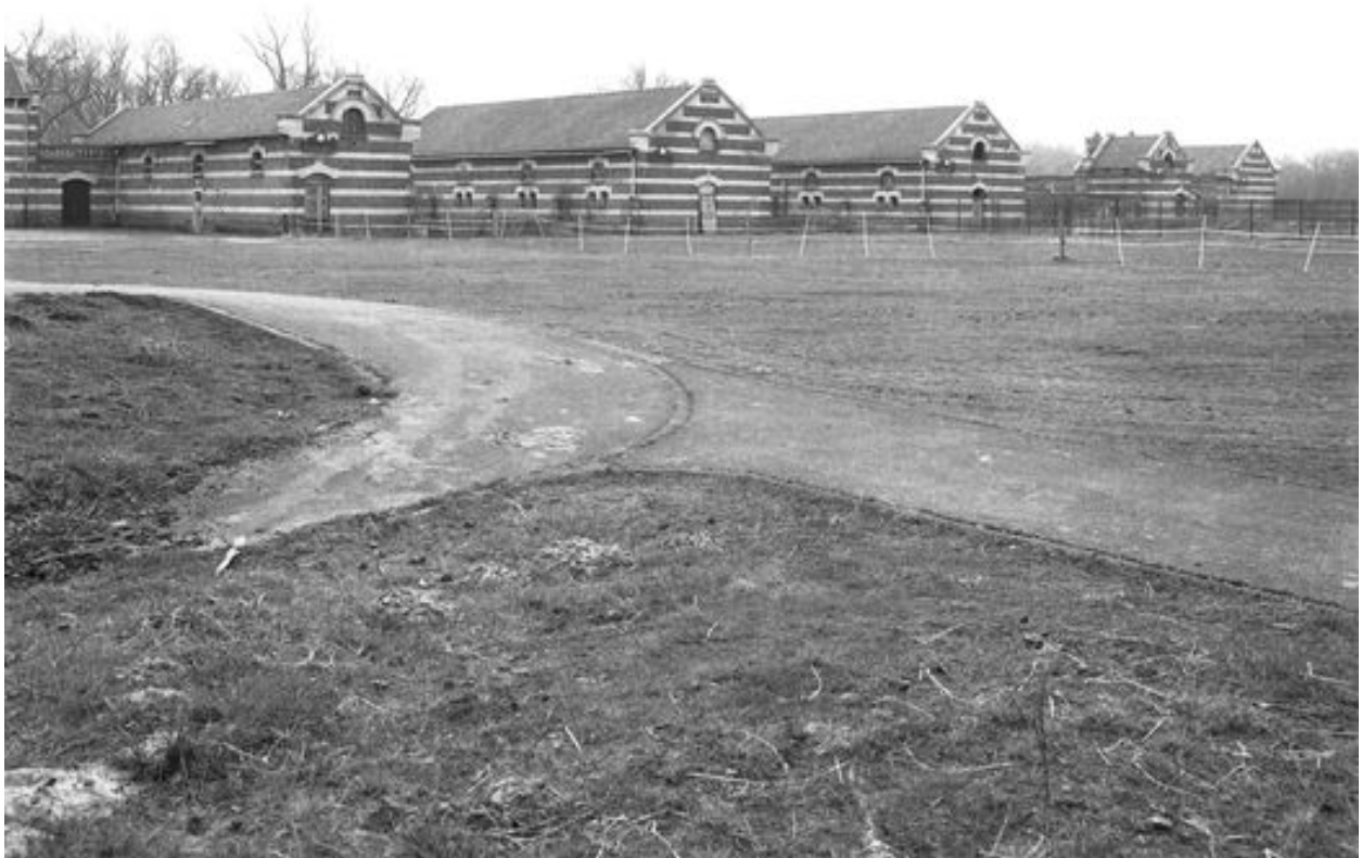
Bâtiments abritant les bergeries et l'abattoir (à droite) au sud-ouest de la cour, vue d'ensemble en 2003.
