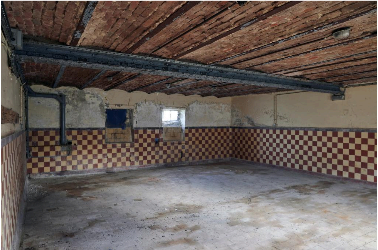
Sous-sol du logement du chef d'élevage.
