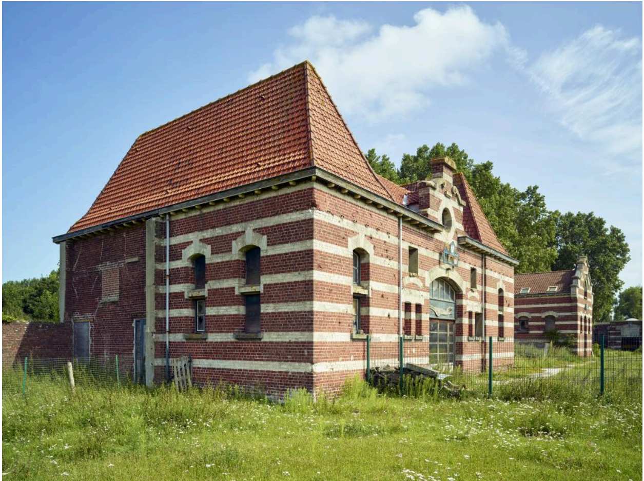
Laiterie et magasin, vue de trois-quarts sud-ouest.
