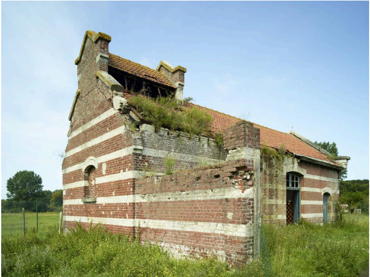
Abattoir, vue d'ensemble sud-est.
