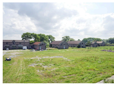
Vue d'ensemble des bâtiments de bergerie et porcherie depuis le nord. Phot. Pierre Thibaut IVR32_20215900182NUCA
