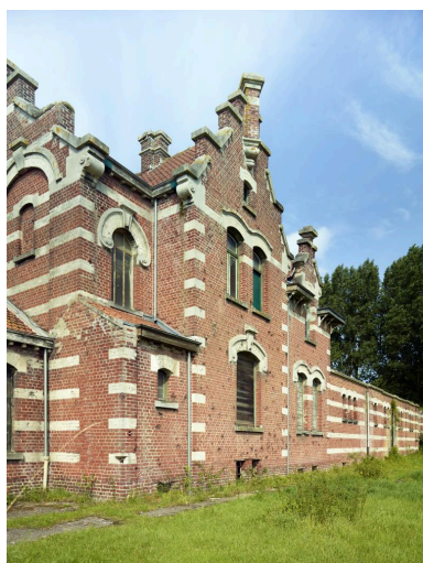
Logement du chef de cultures, vue partielle depuis l'est. Phot. Pierre Thibaut IVR32_20215900206NUCA
