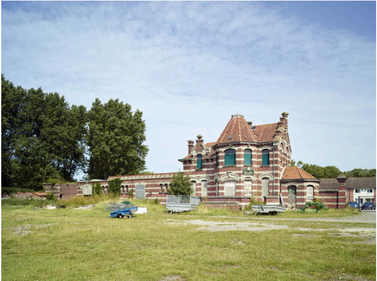
Vue d'ensemble du logement du chef d'élevage, depuis l'ouest.
