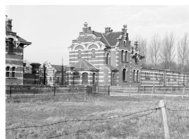
L'entrée principale de la ferme et l'habitation du chef d'élevage à droite. Vue d'ensemble de trois-quarts gauche depuis la route en 2003.
