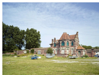
Vue d'ensemble du logement du chef d'élevage, depuis l'ouest. Phot. Pierre Thibaut IVR32_20215900224NUCA
