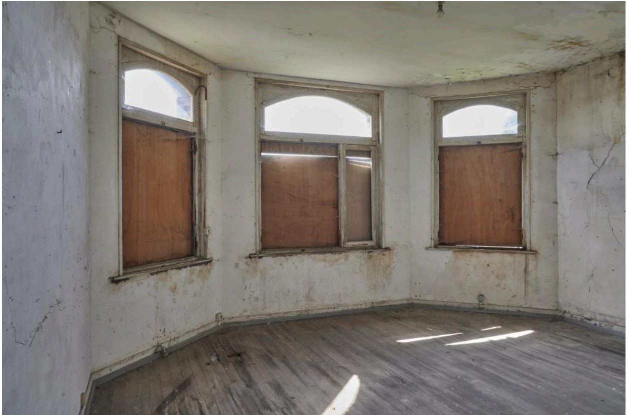
Vue intérieure des ouvertures de la cuisine du logement du chef d'élevage.
