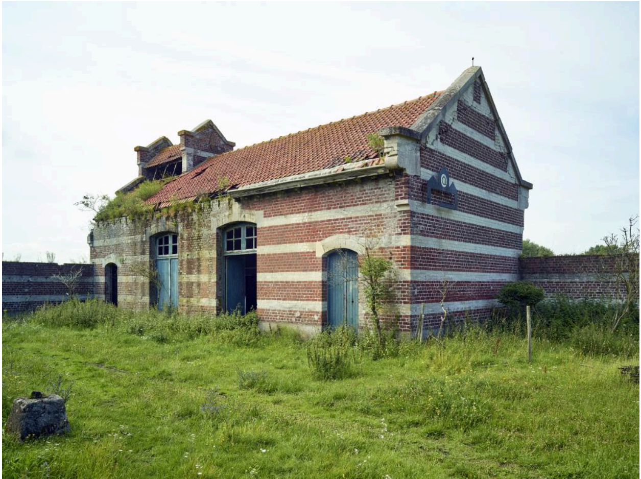
Abattoir, vue d'ensemble nord-est.
