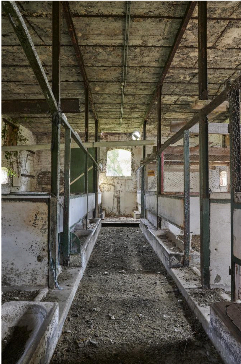
Vue intérieure d'une des porcheries.
