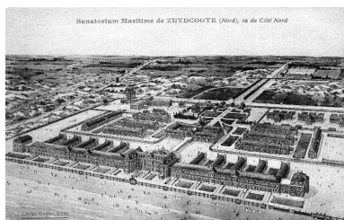
Vue aérienne générale du sanatorium avec au fond à droite la ferme du Nord. Carte postale, début du 20e siècle.
