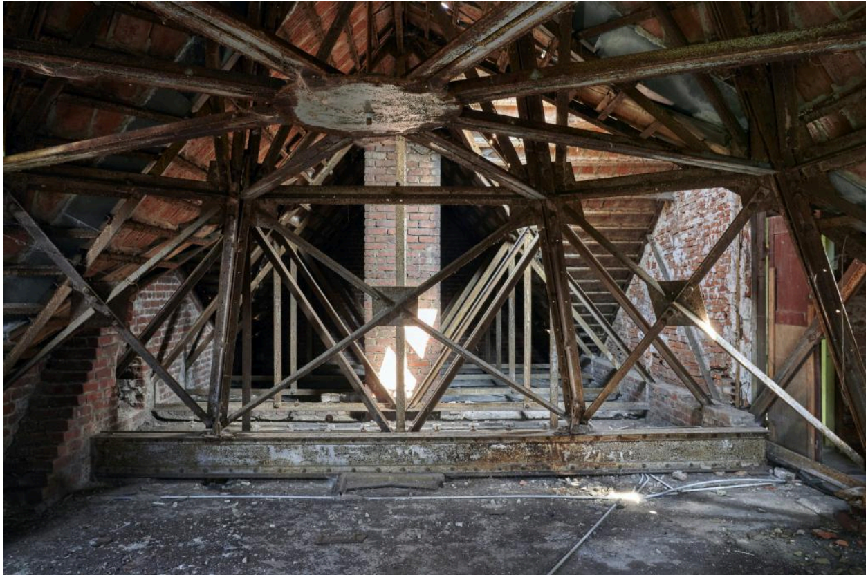
Charpente métallique sous combles du logement du chef d'élevage.
