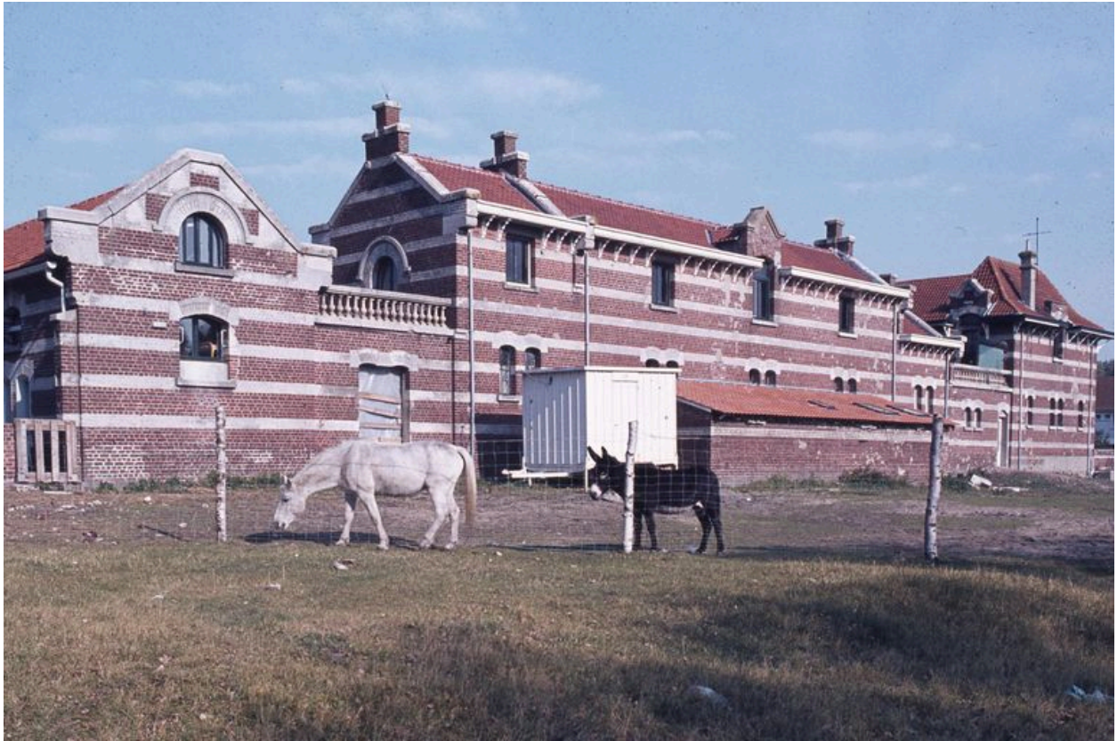
Bâtiments fermant la cour au sud, élévation extérieure en 1980.
