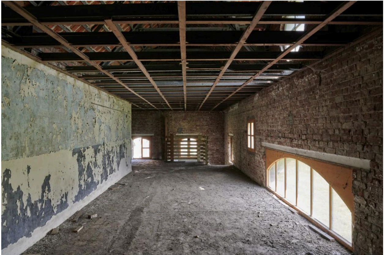
Combles des anciens magasins.
