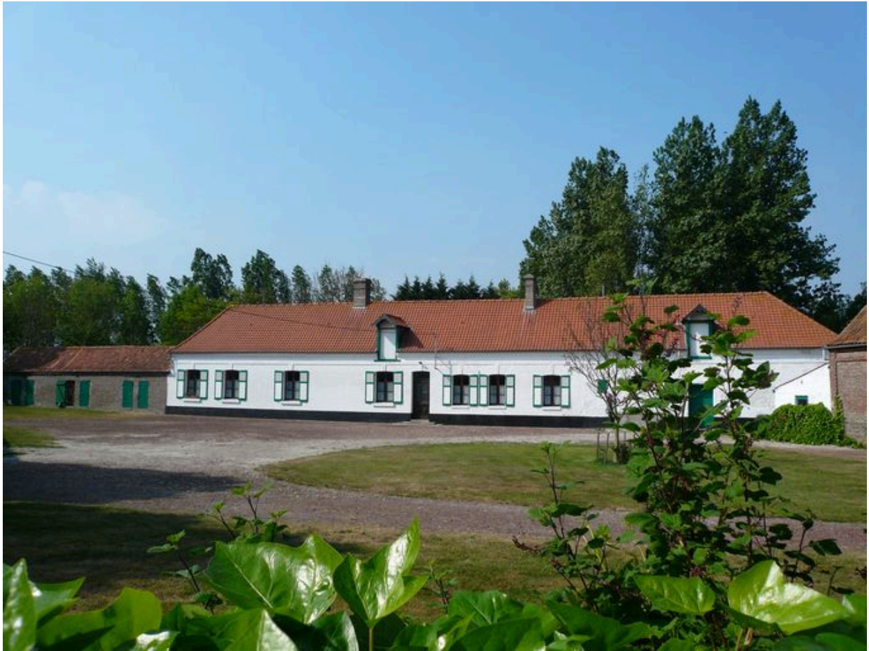
Vue du logis, flanqué à l'est des écuries et à l'ouest, des porcheries.
