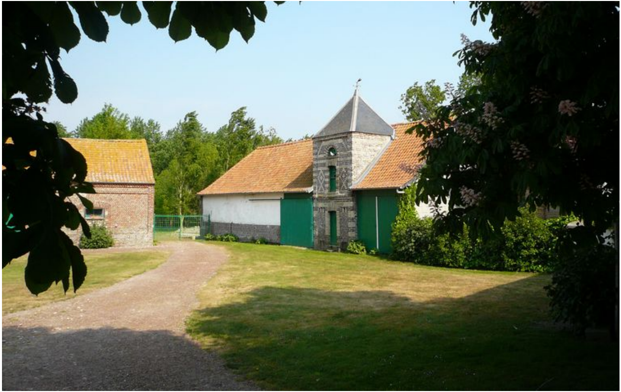
Vue de la grange avec pigeonnier intégré depuis la cour au sud de celle-ci.
