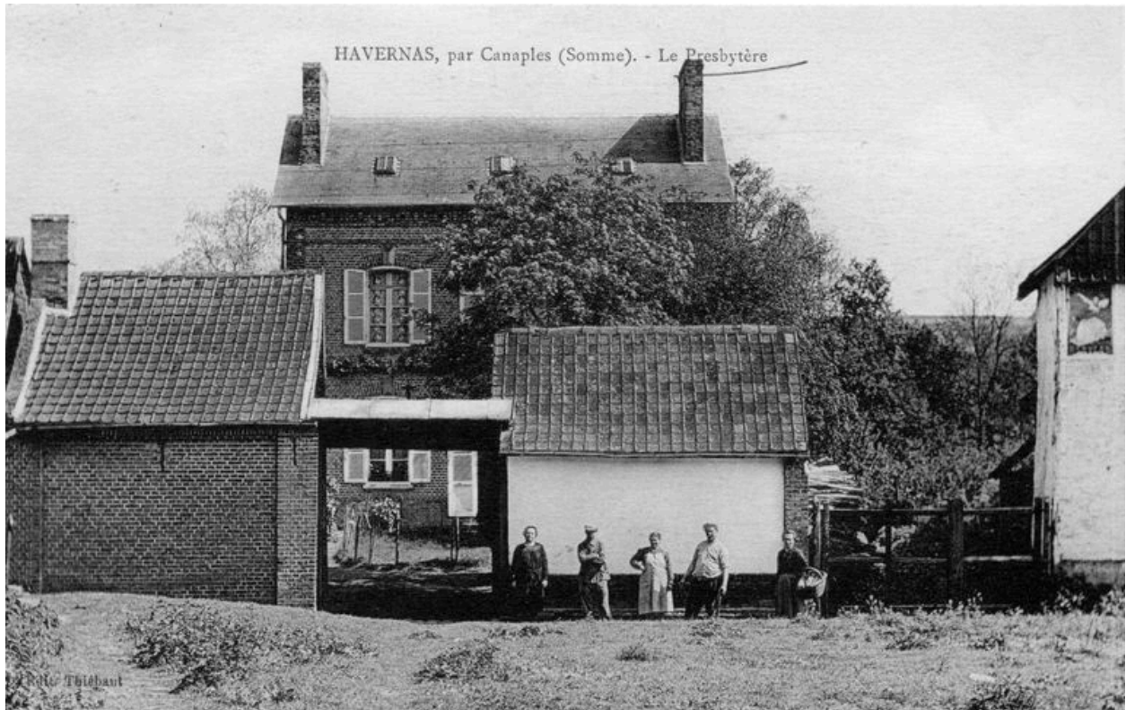
Vue générale depuis la rue, 1920-1930 (coll. part.).
